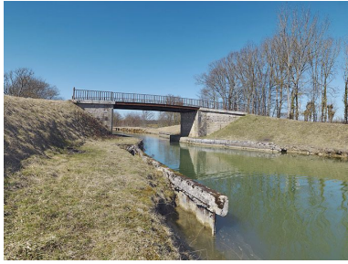
Vue d'ensemble du pont.
