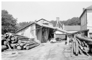
Scierie. Phot. Laurent Poupard IVR43_19923901193Z
