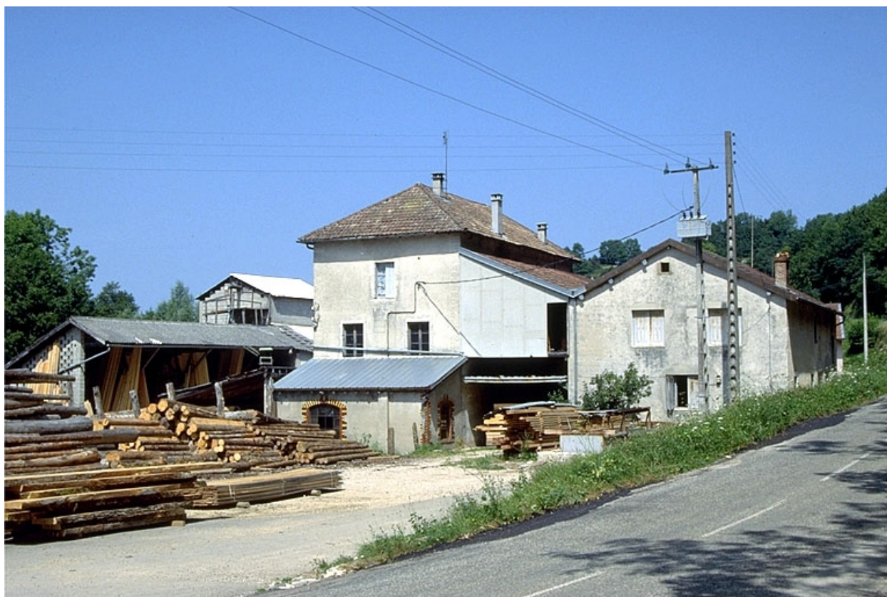
Scierie, ancienne tournerie et ancienne huilerie.
