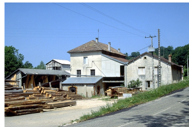
Scierie, ancienne tournerie et ancienne huilerie. Phot. Laurent Poupard IVR43_19923901192ZA
