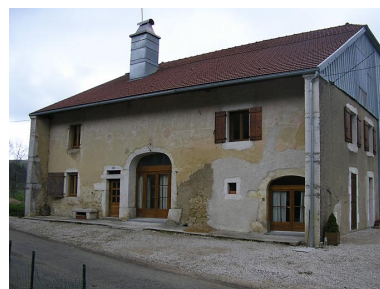
Ferme située au lieu-dit La Ruine. Phot. Marie-Pierre Reynet IVR43_20083900408NUC1A
