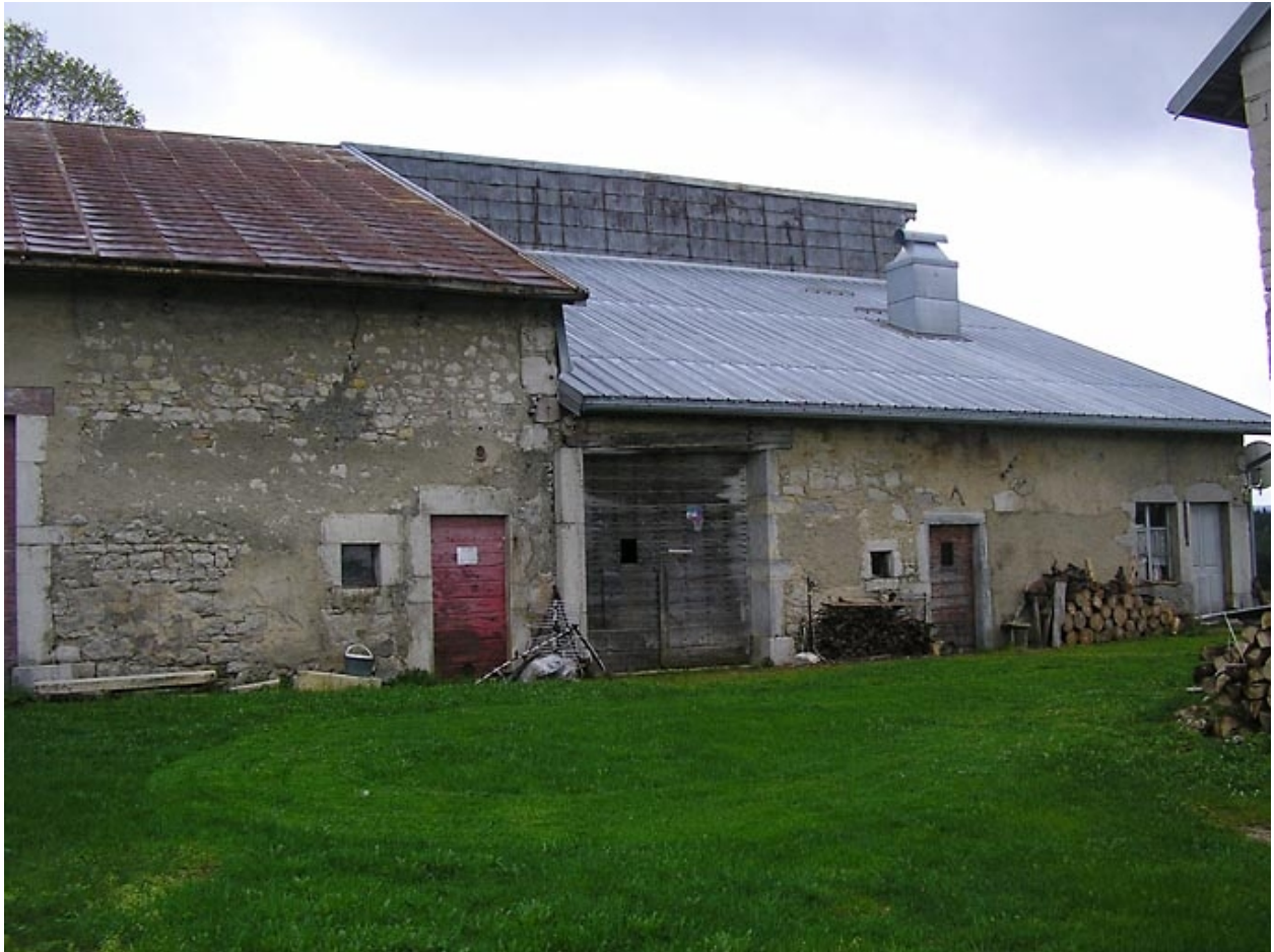
Ferme située au lieu-dit Le Coin d'Aval.
