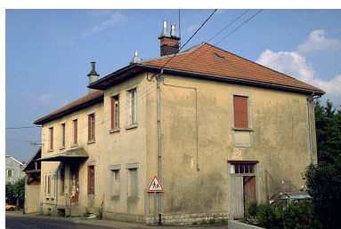
La fromagerie. Phot. Laurent Poupard IVR43_19913901164ZA
