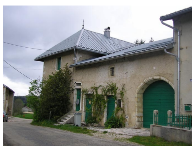
Ferme située au lieu-dit La Ruine. Phot. Marie-Pierre Reynet IVR43_20083900406NUC1A
