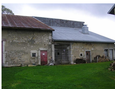
Ferme située au lieu- dit Le Coin d'Aval. Phot. Marie-Pierre Reynet IVR43_20083900411NUC1A
