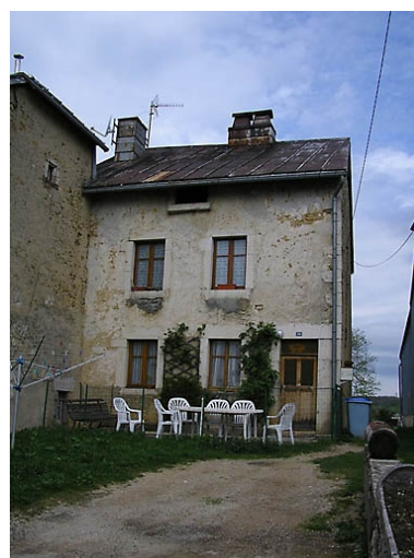
Maison située 164 rue Haut du village. Phot. Marie-Pierre Reynet IVR43_20083900373NUC1A
