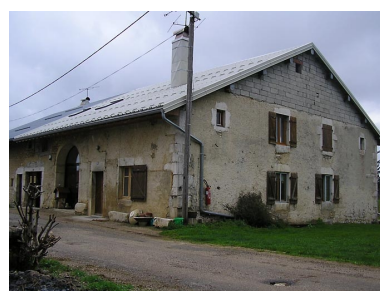
Ferme située au lieu- dit Le Coin d'Aval. Phot. Marie-Pierre Reynet IVR43_20083900413NUC1A
