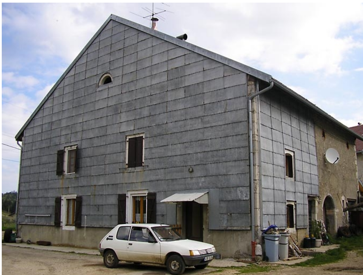
Ferme située au lieu-dit Le Saut.
