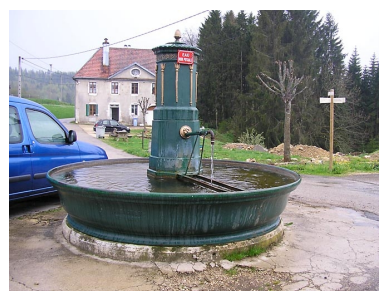
Fontaine située Grande Rue. Phot. Marie-Pierre Reynet IVR43_20083900393NUC1A
