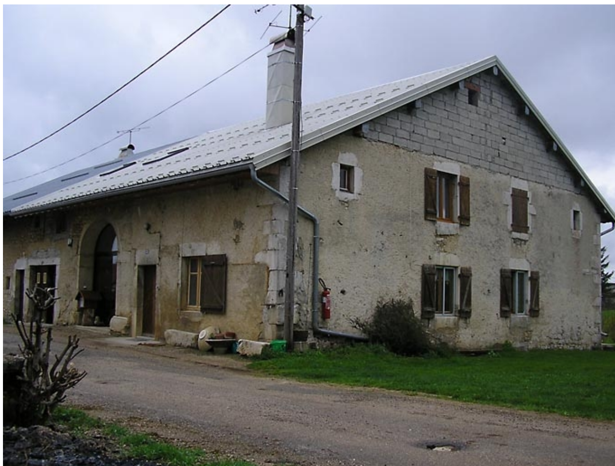
Ferme située au lieu-dit Le Coin d'Aval.
