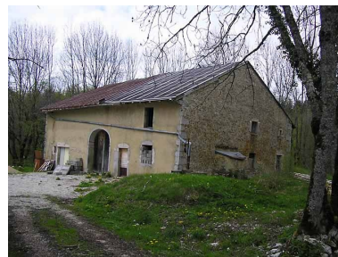
Ferme située au lieu-dit Le Couloir. Phot. Marie-Pierre Reynet IVR43_20083900438NUC1A
