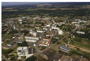
Vue aérienne. Phot. Livdeo IVR26_20195800853NUC2A
