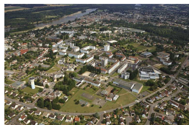
Vue aérienne. Phot. Livdeo IVR26_20195800857NUC2A
