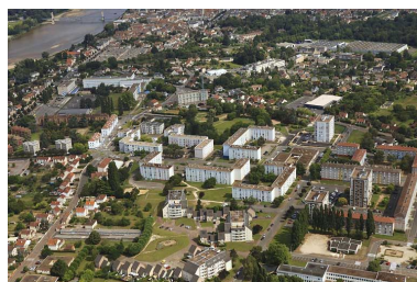
Vue aérienne. Phot. Livdeo IVR26_20195800856NUC2A
