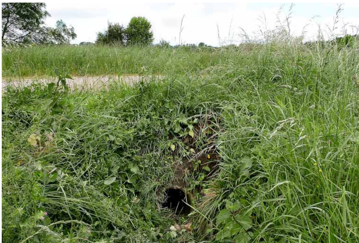
Un aqueduc moderne à Sornay.
