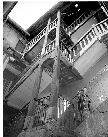
Escalier dans la cour. Phot. Yves Sancey IVR43_19833900194X
