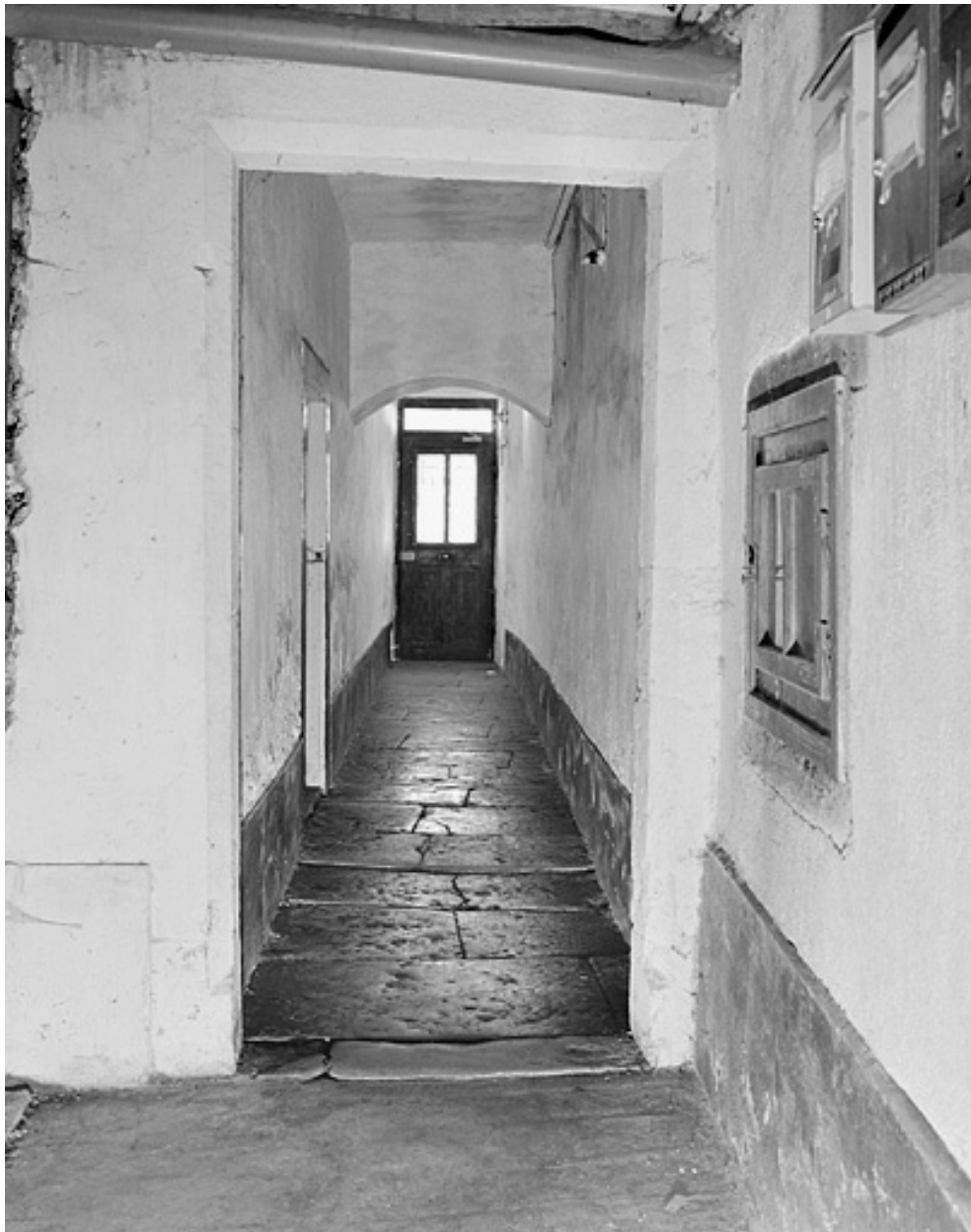
Allée du premier corps de bâtiment.
