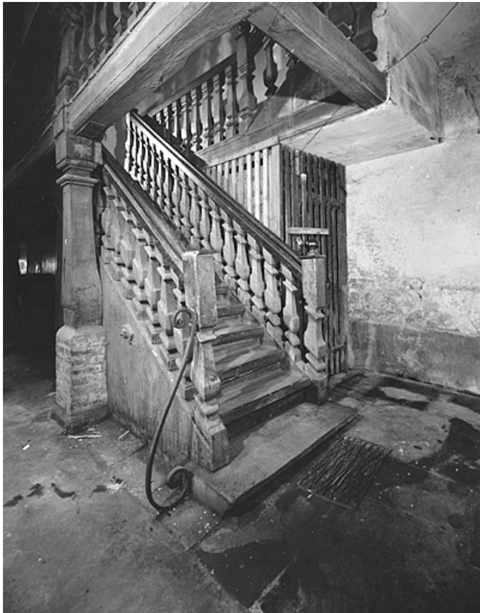
Escalier, première volée.
