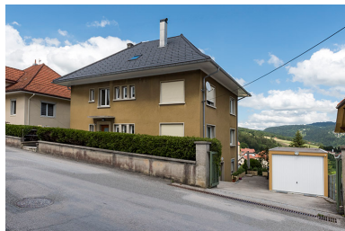
Façades antérieure et latérale droite.
