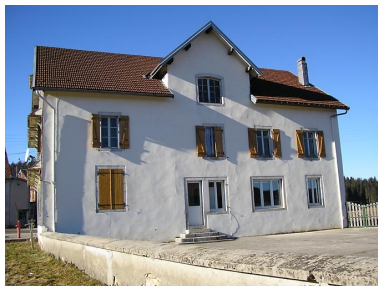
Façade postérieure. Phot. Marie-Pierre Reynet IVR43_20083900472NUC1A
