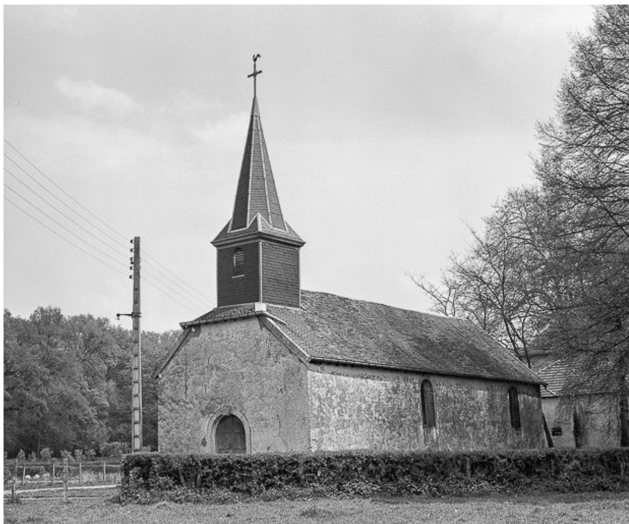
Façades antérieure et latérale droite.
