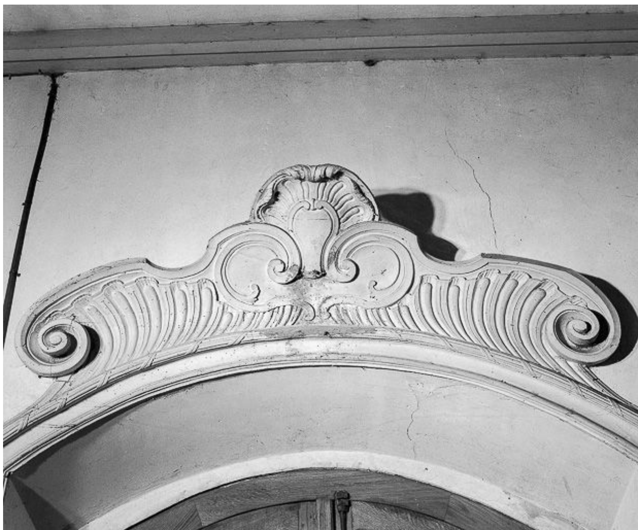
Intérieur : couronnement de la porte d'entrée.
