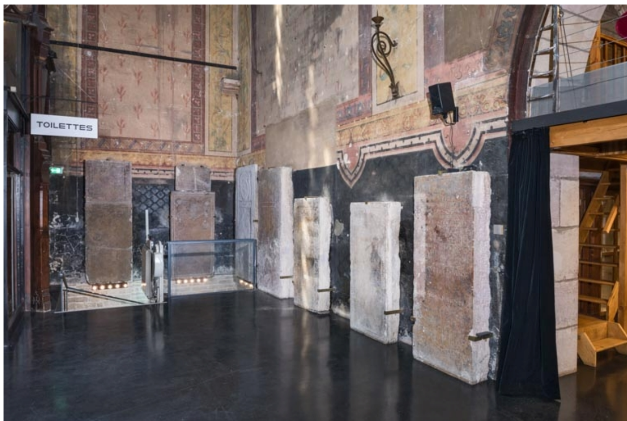
Dalles funéraires dans l'angle nord-ouest.
