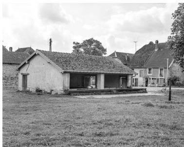
Faces latérale et postérieure. Phot. Dominique Dominguez IVR43_19807000165X
