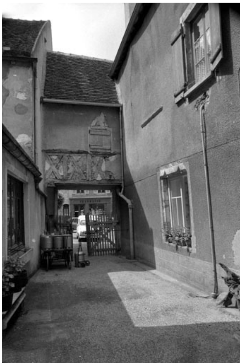
Détail passerelle couverte au-dessus de l'impasse.
