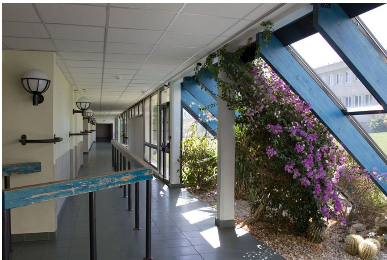
Restauration : couloir côté sud.
