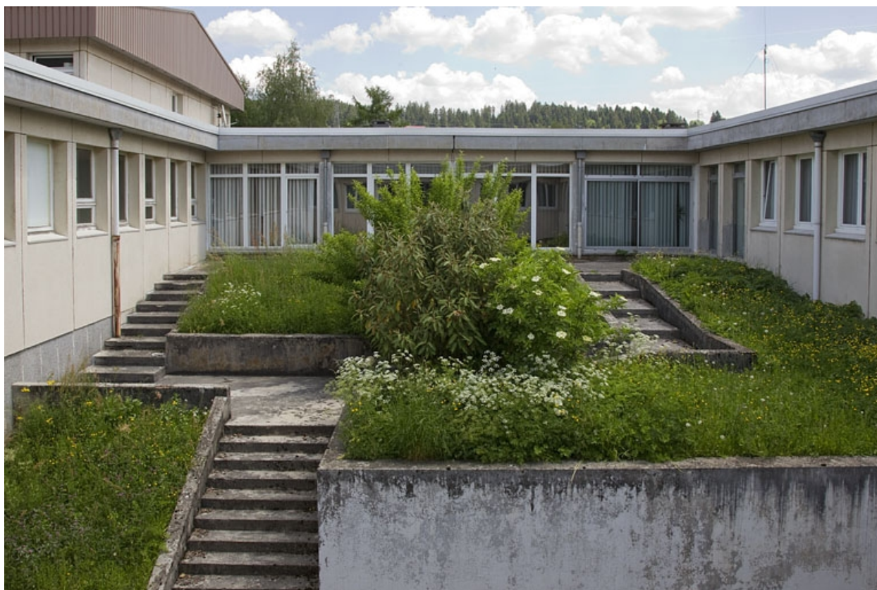
Bâtiment de l'administration : patio.
