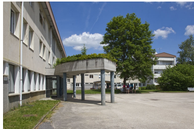
Bâtiments de l'infirmerie et des salles techniques-internat. Phot. Yves Sancey IVR43_20122500781NUC2A
