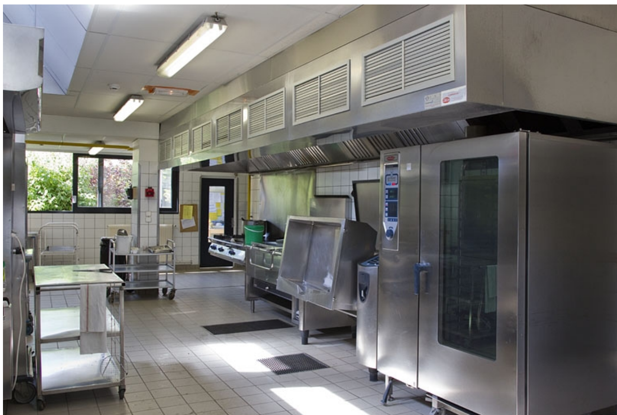
Restauration : la cuisine.
