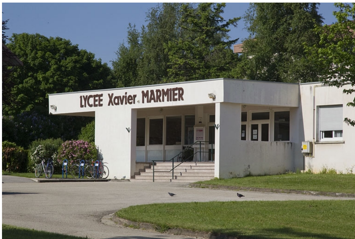
Bâtiment de l'administration : entrée.
