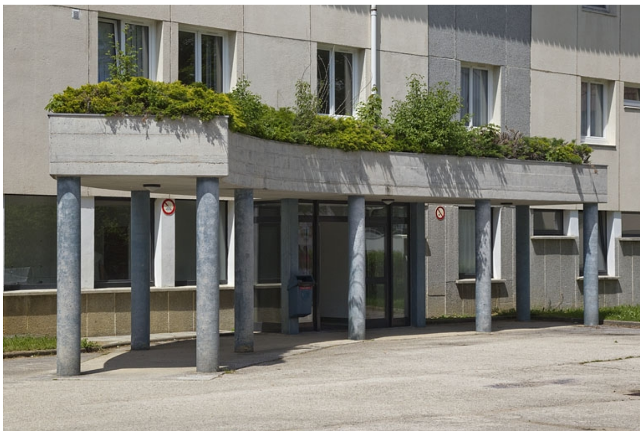
Bâtiment de l'infirmerie : portique.
