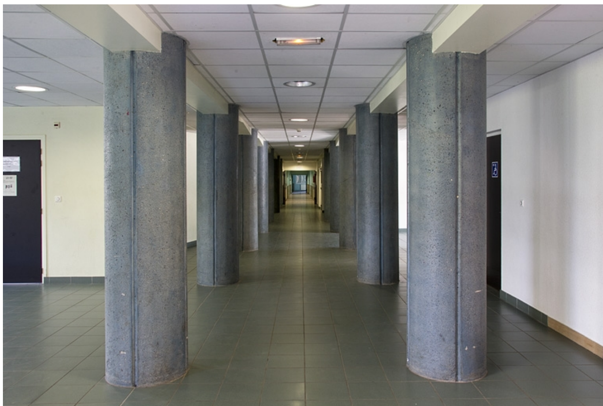
Bâtiment de l'infirmerie : colonnes.
