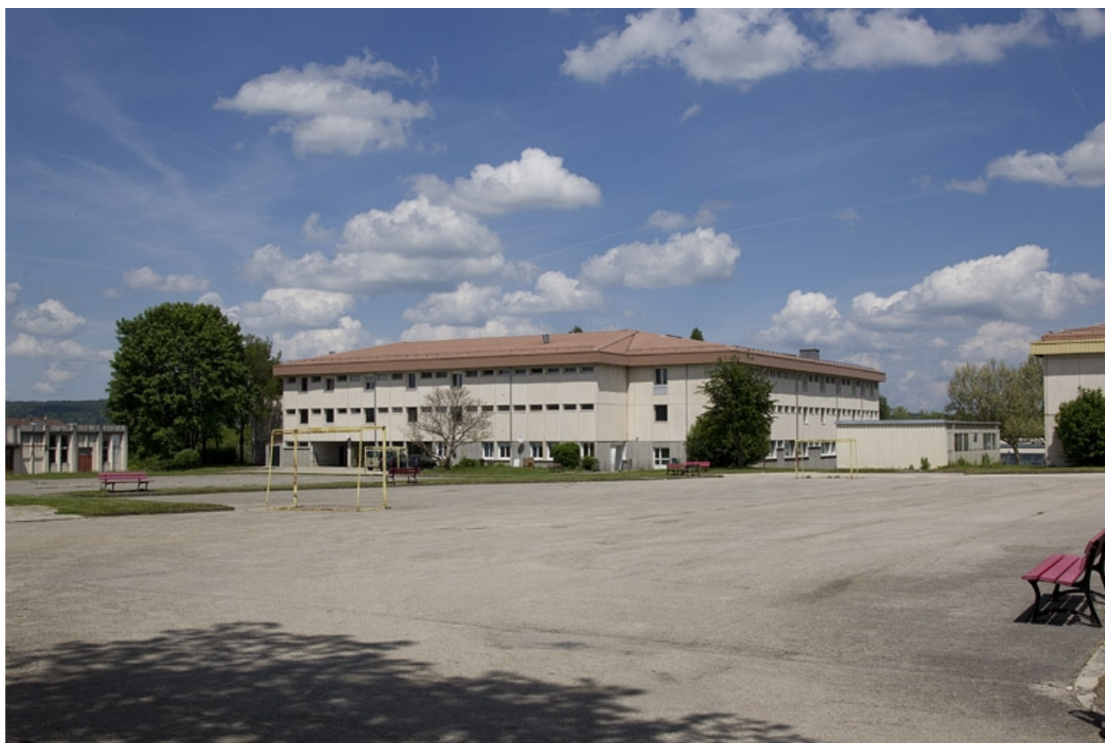
Bâtiment de l'internat ouest, vu du sud.
