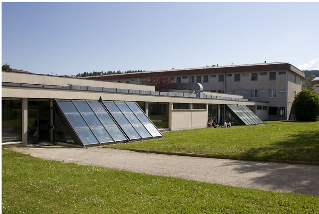
Bâtiment de la restauration : face sud.
