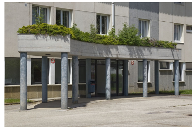
Bâtiment de l'infirmerie : portique. Phot. Yves Sancey IVR43_20122500780NUC2A
