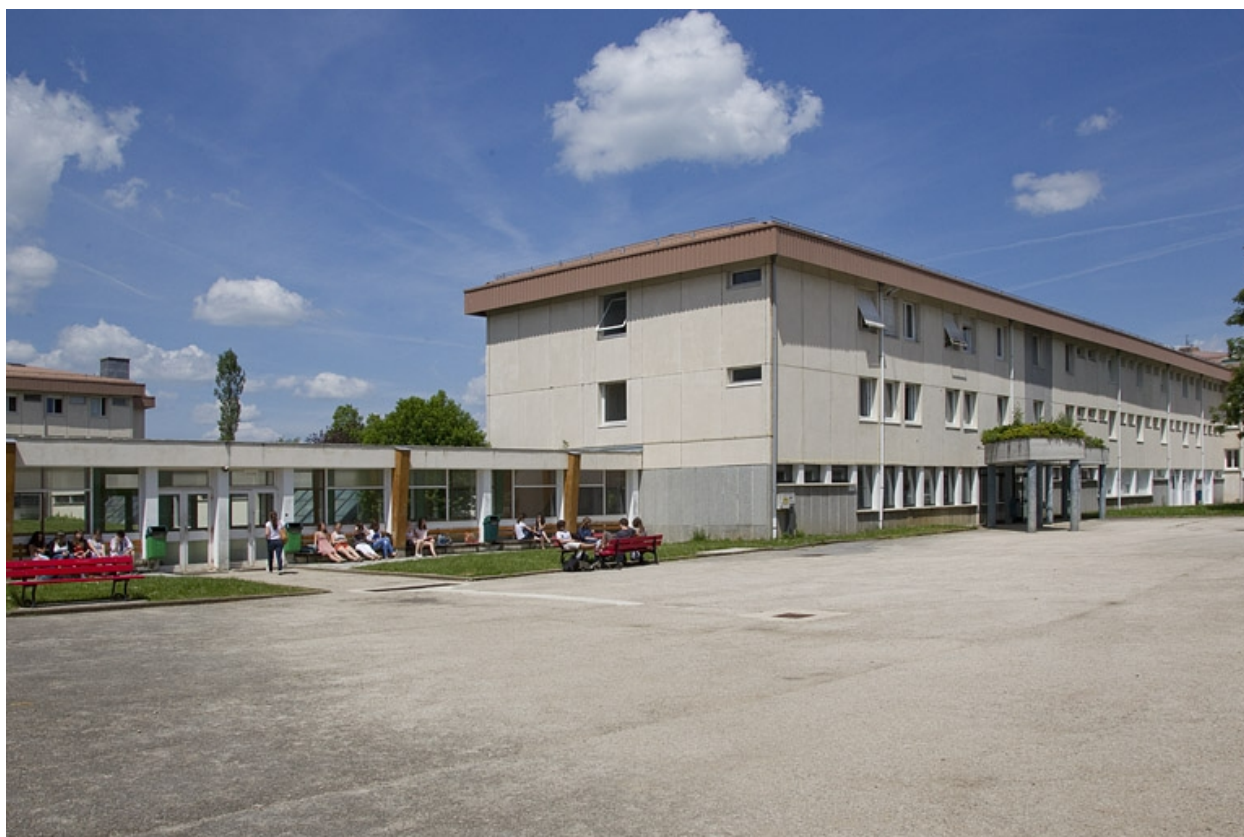
Galerie et bâtiment de l'infirmerie.
