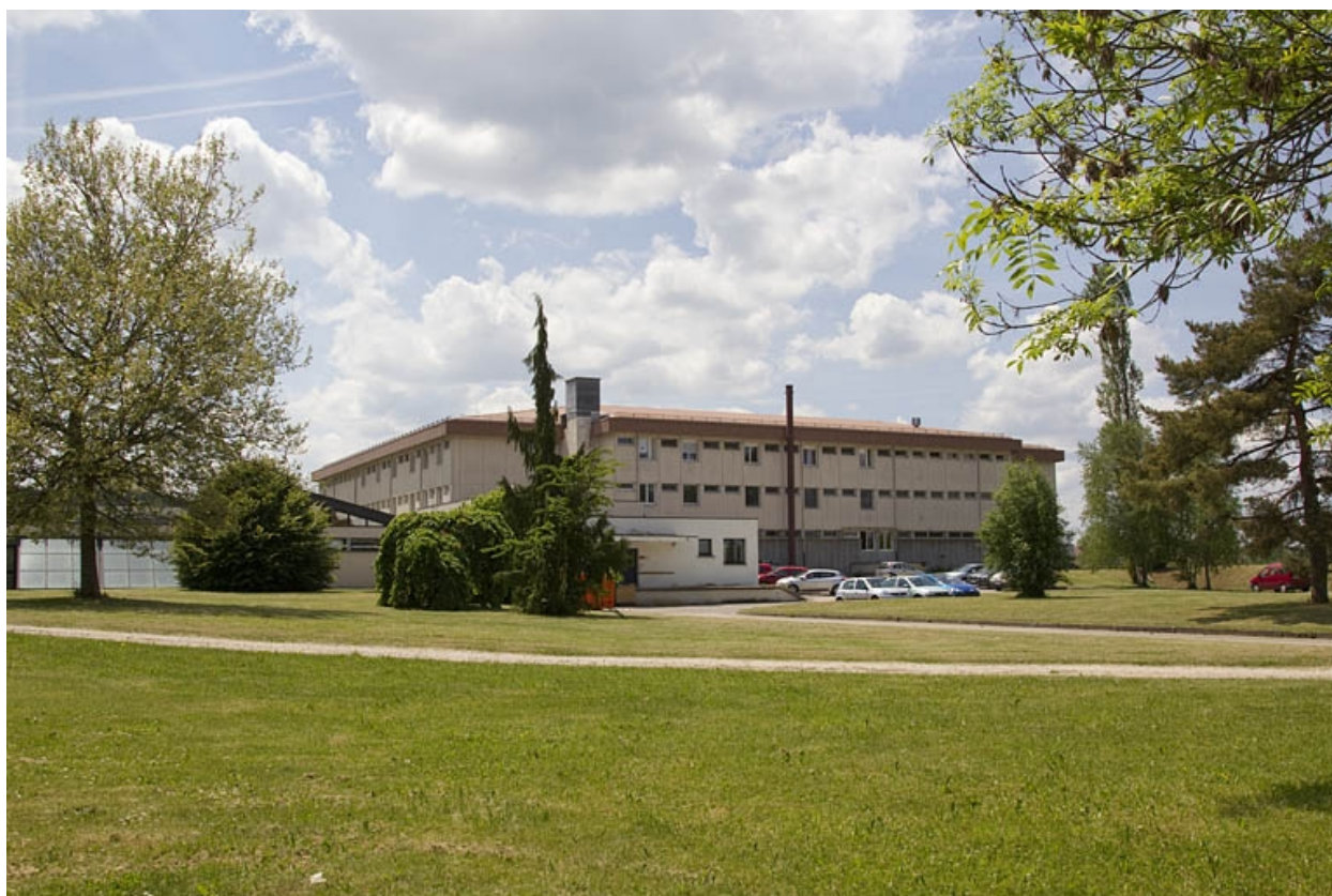
Bâtiment de l'internat ouest, vu du nord.
