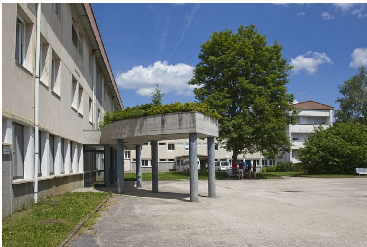
Bâtiments de l'infirmerie et des salles techniques-internat.
