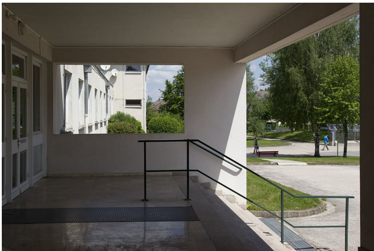
Bâtiment de l'administration : entrée couverte.
