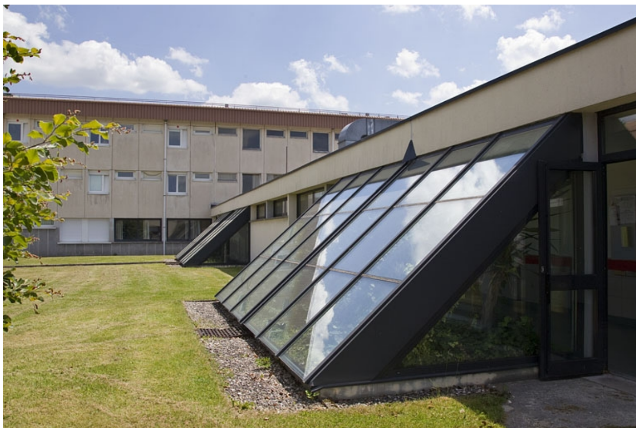
Bâtiment de la restauration : face nord.
