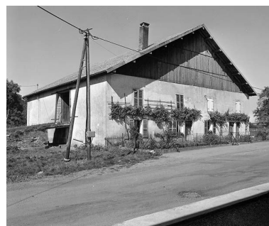
Ferme située chemin du Sel.
