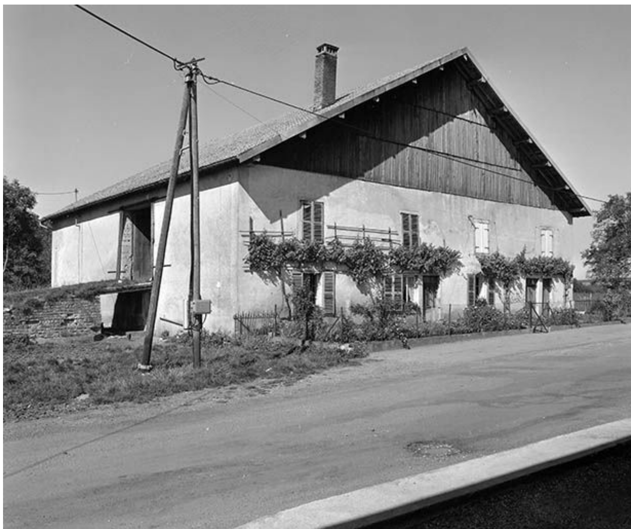
Ferme située chemin du Sel.
