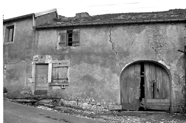
Façade sur rue. Phot. Bernard Lardière IVR43_19777000168X
