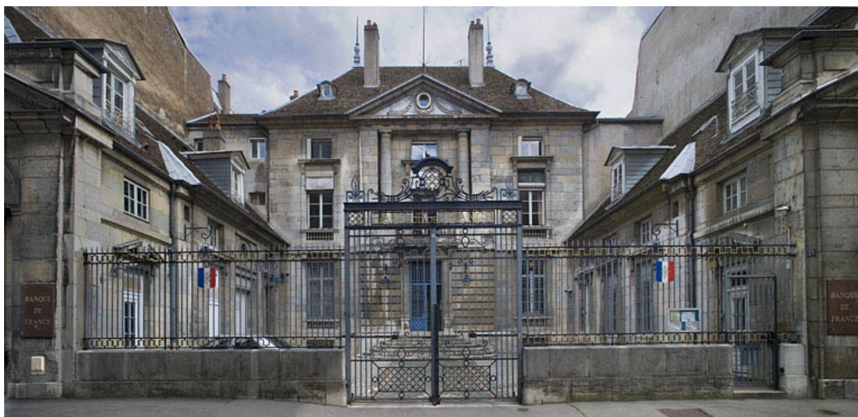
Vue d'ensemble de face depuis la rue.
