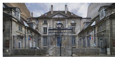
Vue d'ensemble de face depuis la rue.
