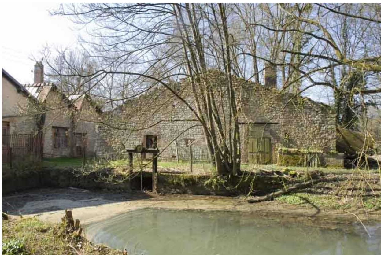
Bief d'amenée et pignon de l'entrepôt industriel (?).
