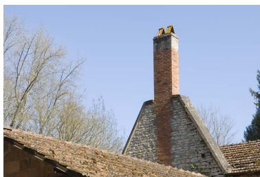
Cheminée. Phot. Jérôme Mongreville IVR43_20097000283NUC2A
