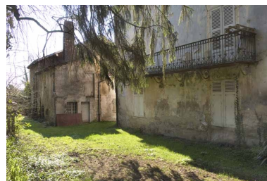
Logement patronal et ses dépendances. Phot. Jérôme Mongreville IVR43_20097000279NUC2A
