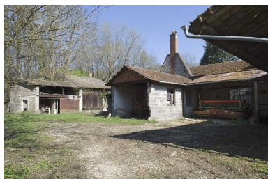
Dépendances à l'ouest. Phot. Jérôme Mongreville IVR43_20097000284NUC2A
