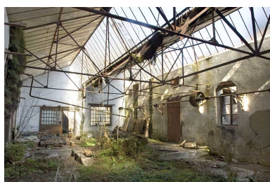
Intérieur d'un atelier de fabrication. Phot. Jérôme Mongreville IVR43_20097000280NUC2A
