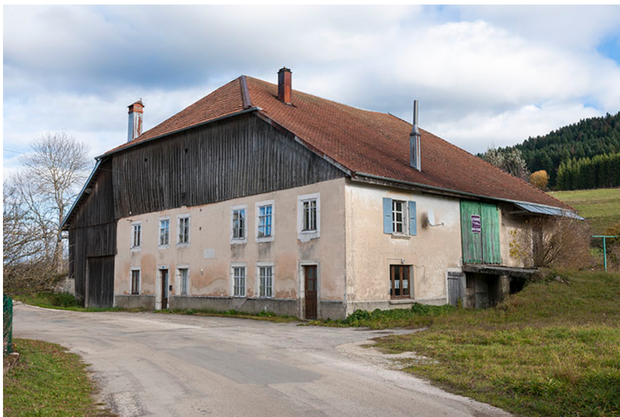
Vue depuis le sud-ouest.
