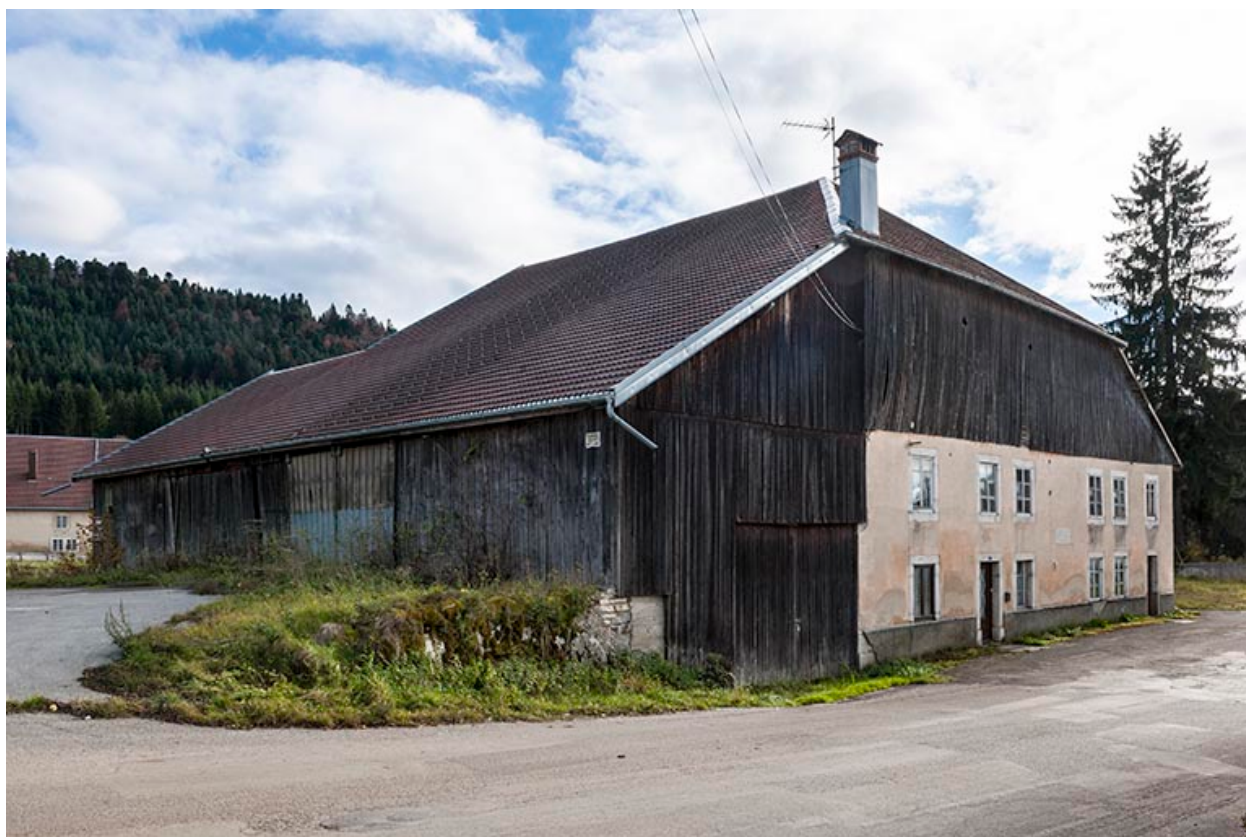
Vue depuis le nord.
