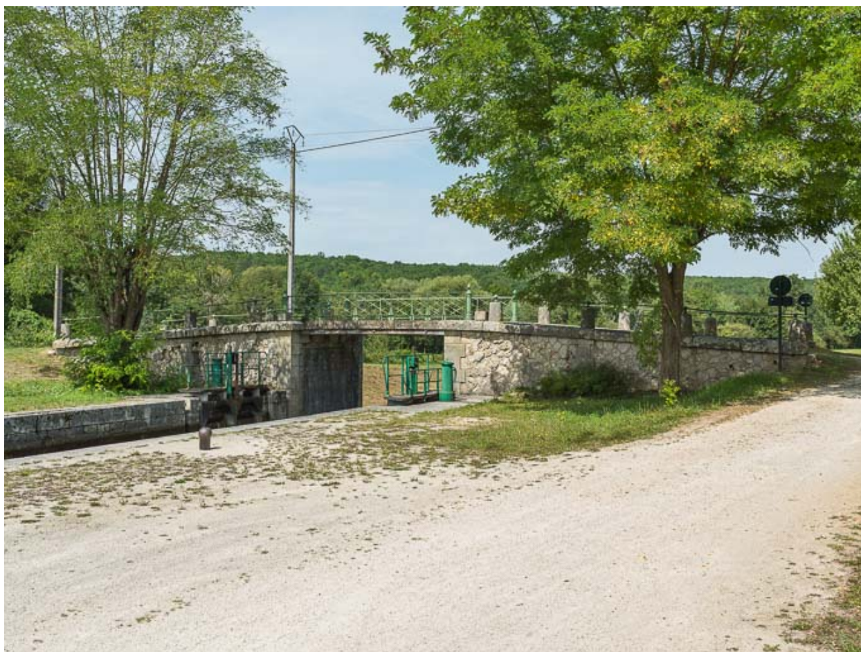
Vue d'ensemble du pont.
