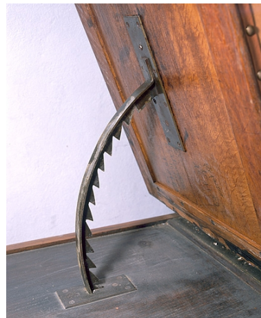
Mécanisme d'inclinaison du dossier. Phot. Jérôme Mongreville IVR43_20042500066XA
