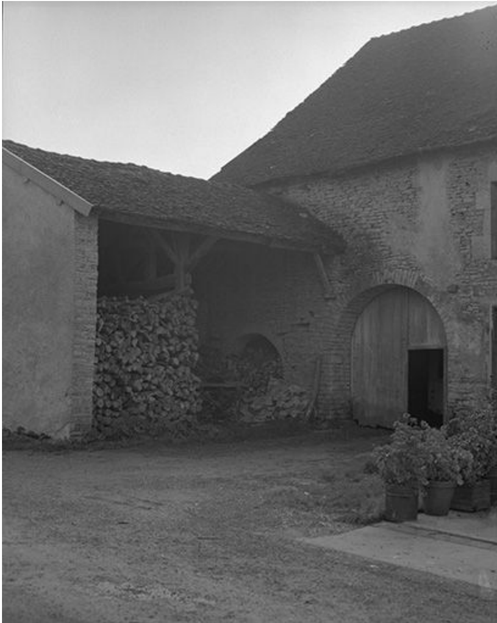
Bûcher et porte de grange de ferme.
