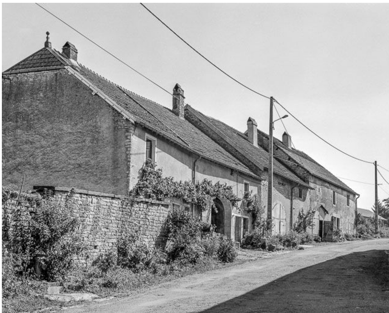
Maisons situées rue Principale.
