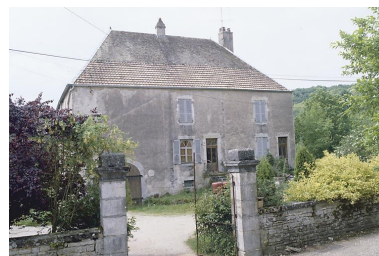
Maison située rue des Corvées. Phot. Yves Sancey IVR43_19867000064XA
