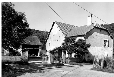
Ferme située rue des Corvées. Phot. Dominique Dominguez IVR43_19807000129X
