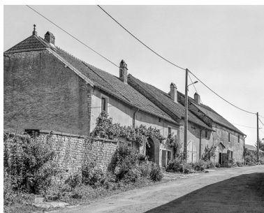
Maisons situées rue Principale. Phot. Dominique Dominguez IVR43_19807000125X
