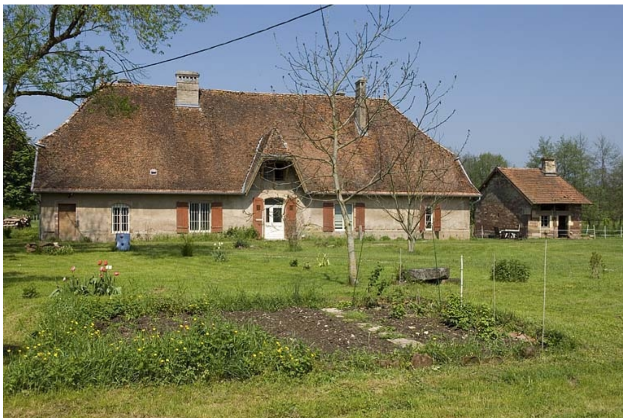
Logement ouvrier collectif.
