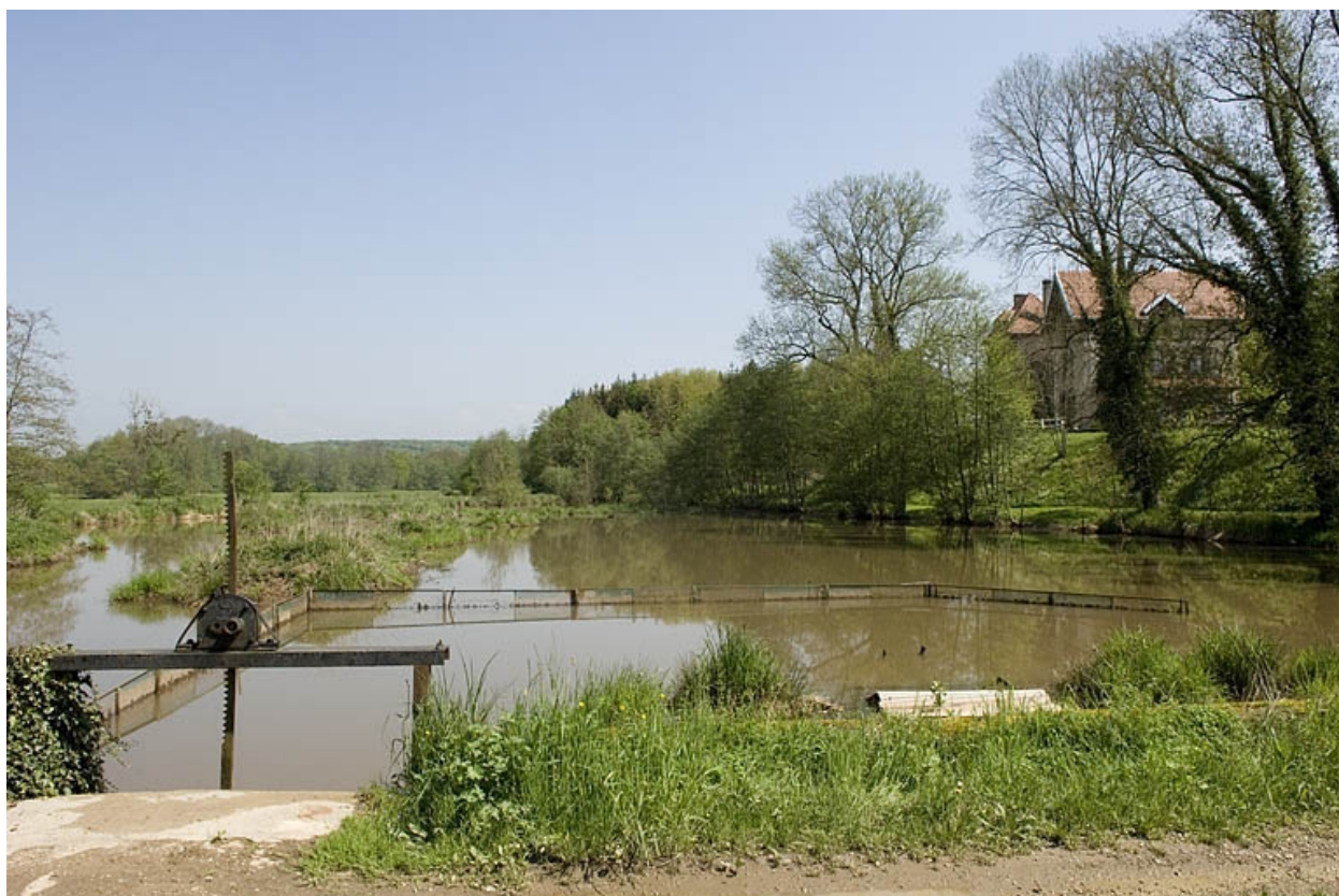
Bassin de retenue.
