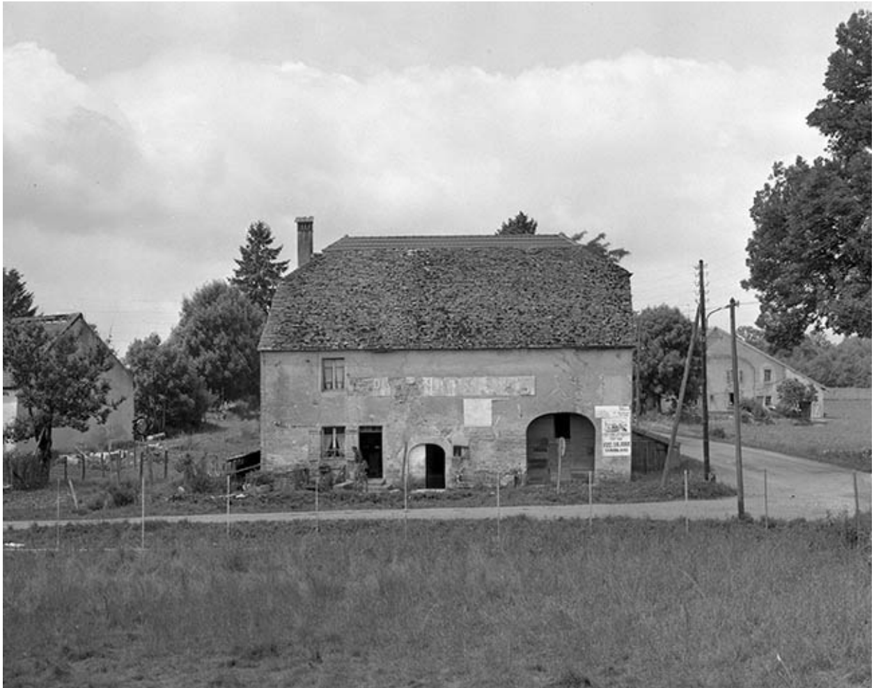
Façade antérieure, vue de face.
