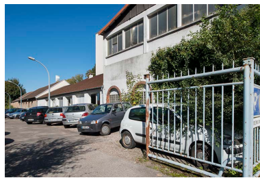
Ateliers de la fonderie. Façades ouest. Phot. Jérôme Mongreville IVR43_20172501335NUC4A
