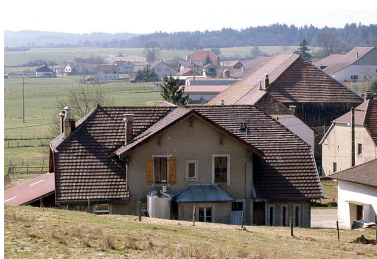
Façade postérieure. Phot. Yves Sancey IVR43_19973900585ZA
