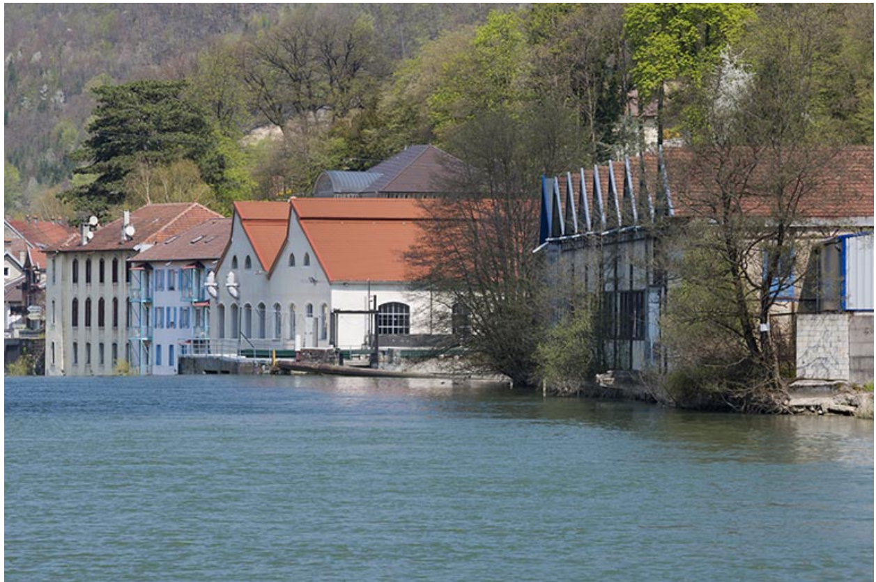
Vue de l'usine rive droite depuis l'amont.
