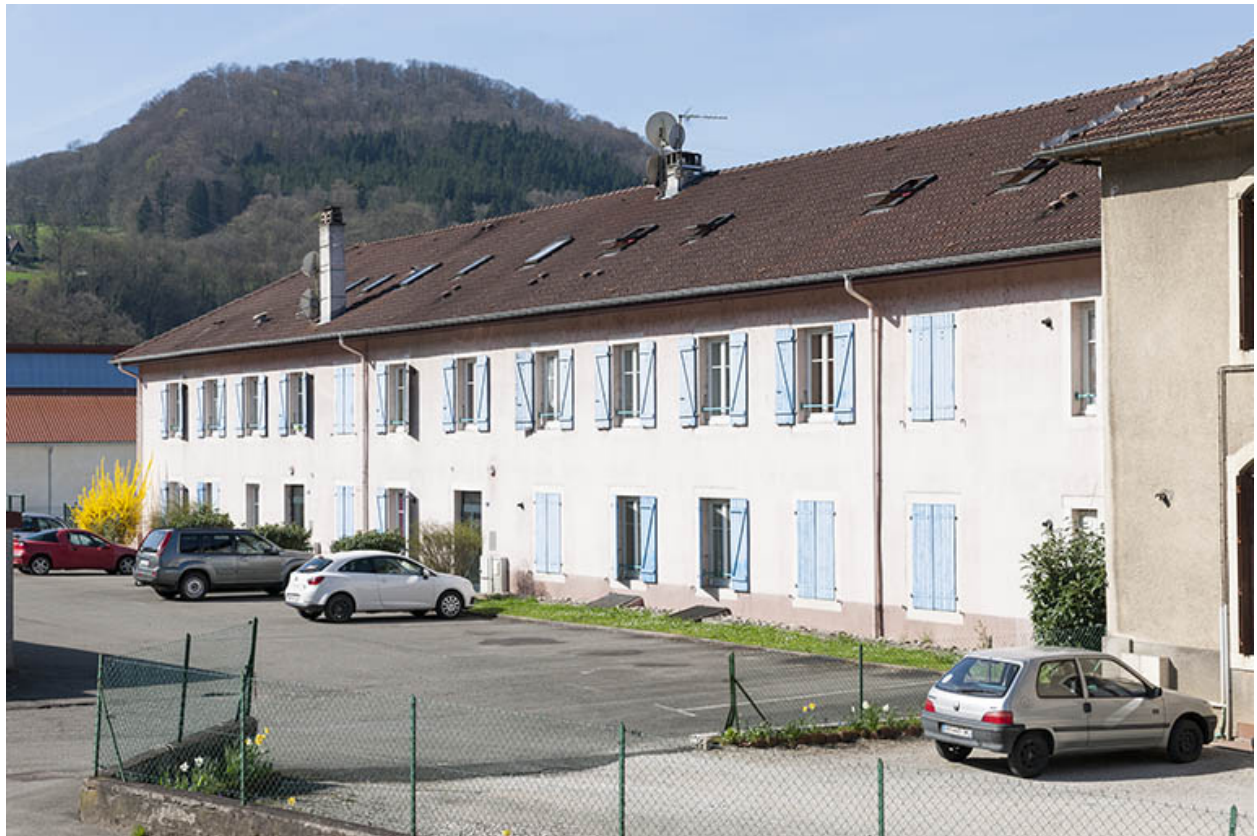
Bâtiment de bureaux (rive droite).
