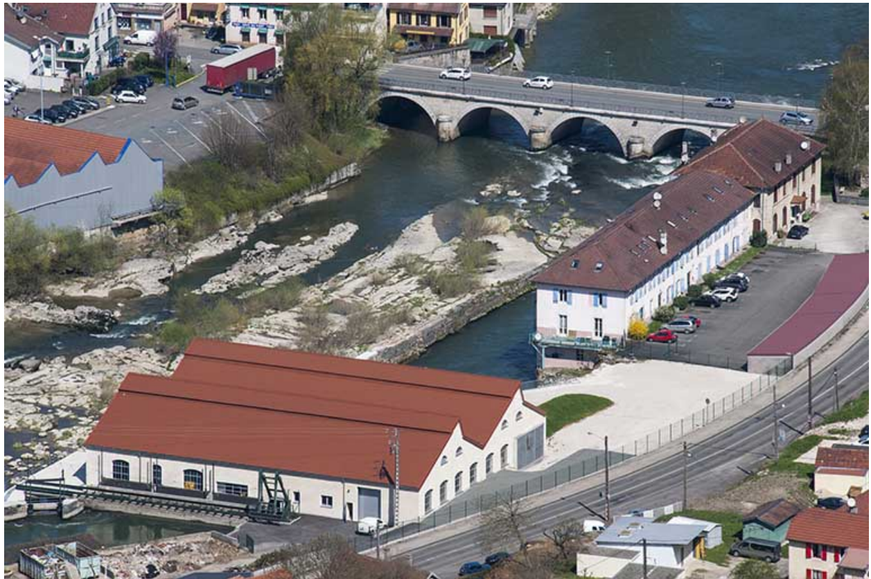
Bâtiments de bureaux en aval du site.
