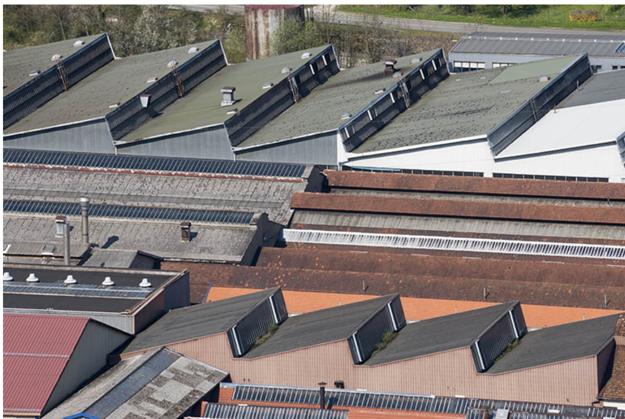
Détail de toitures des bâtiments industriels.
