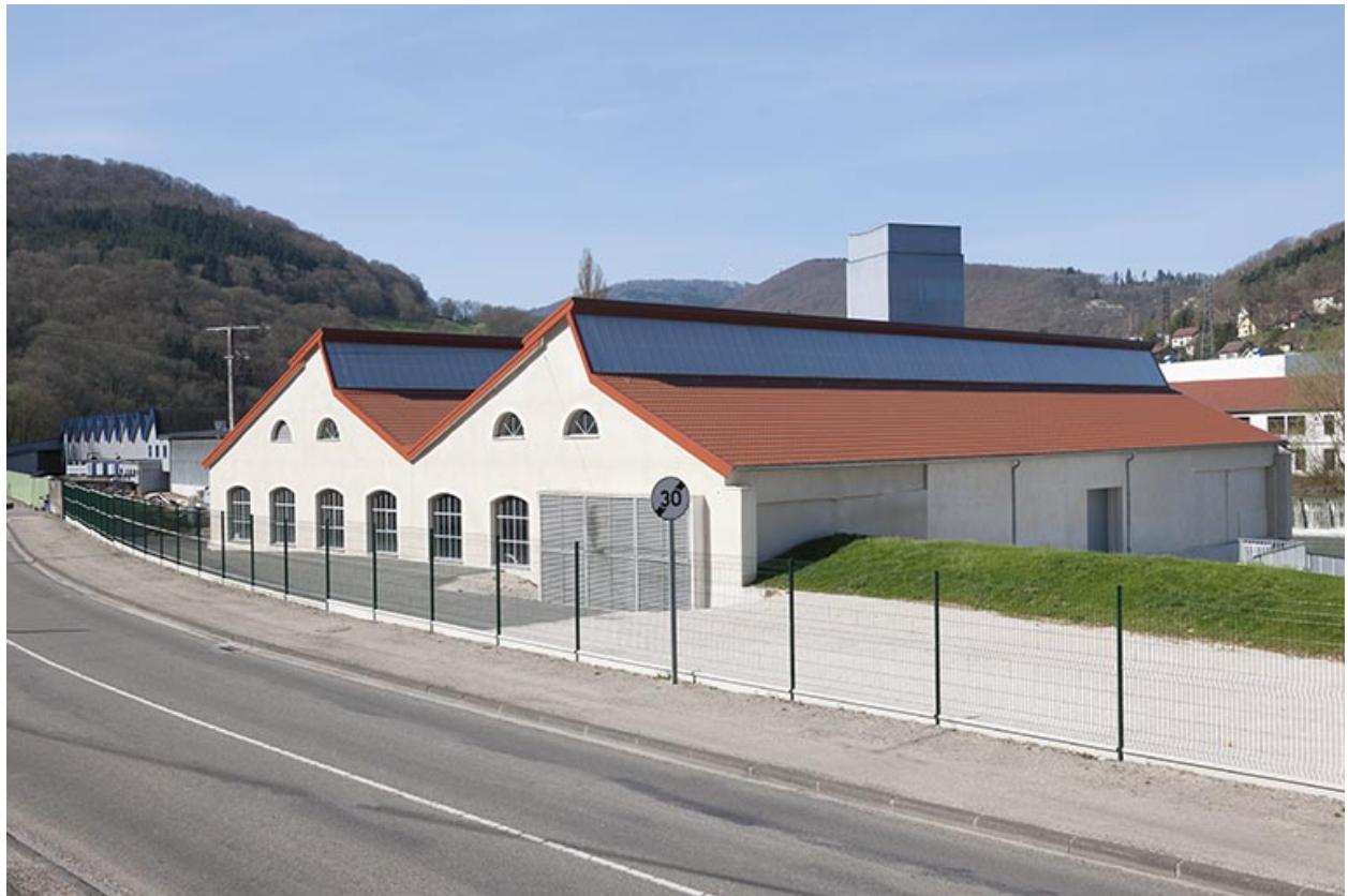
Centrale hydroélectrique (rive droite).
