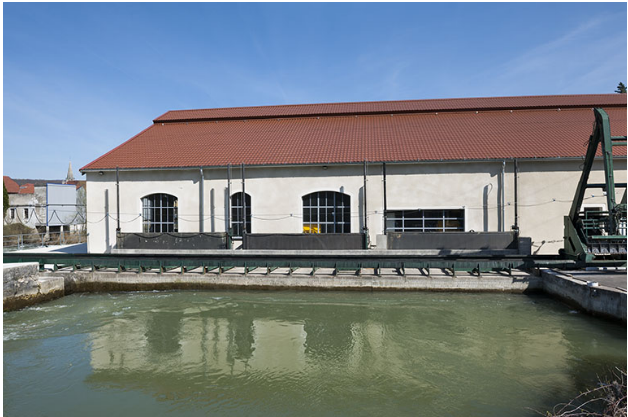
Bief d'amenée de la centrale hydroélectrique.
