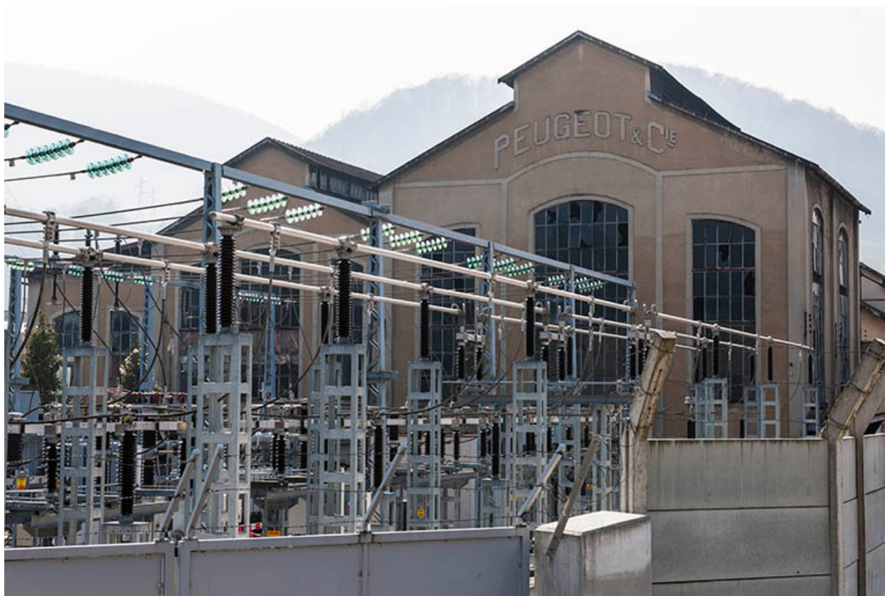
La centrale thermique.
