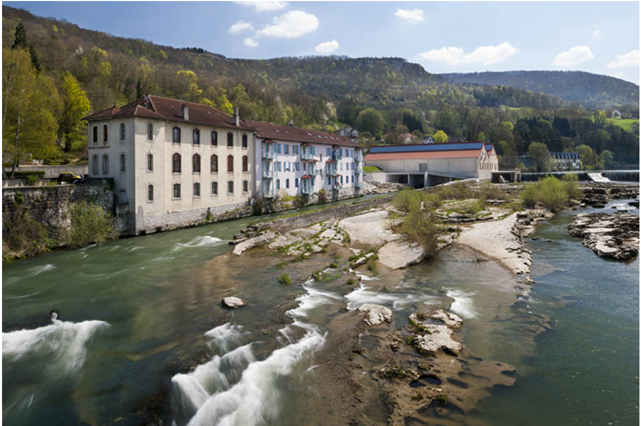
Usine rive droite depuis le pont.
