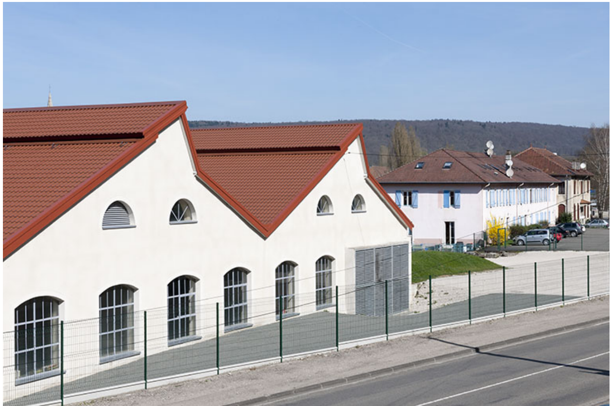
Pignons de la centrale hydroélectrique.
