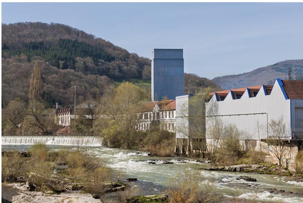
Usine rive gauche. Vue depuis le pont.
