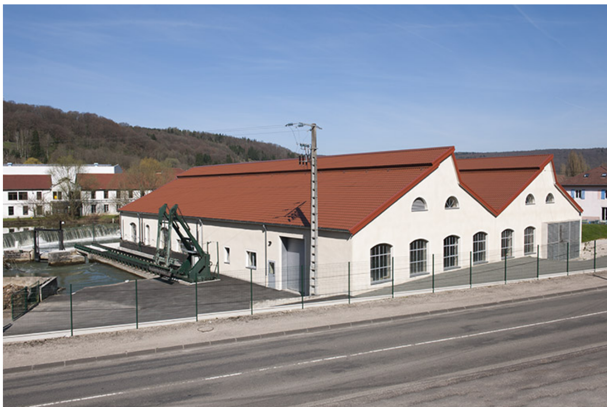
La centrale hydroélectrique vue de trois quarts.
