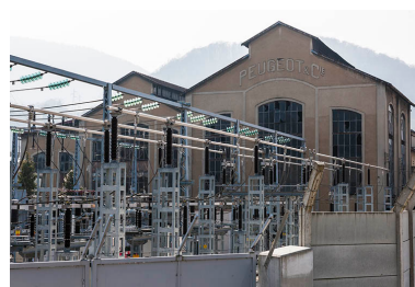
La centrale thermique. Phot. Jérôme Mongreville IVR43_20152500404NUC4A
