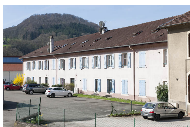
Bâtiment de bureaux (rive droite).
