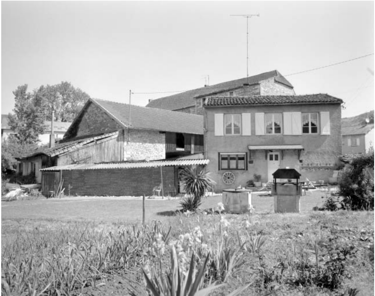
Parties agricoles et logement depuis le sud-ouest.
