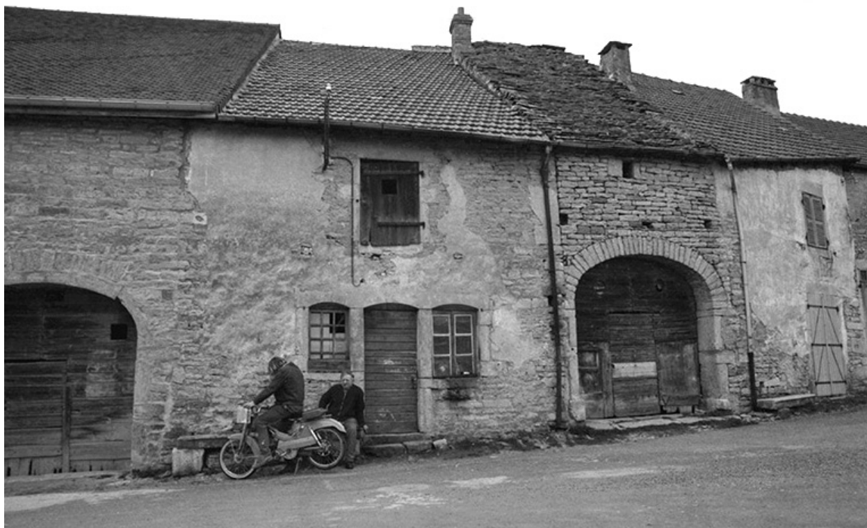
Ferme cadastrée 1965 AB 249 et 252 : façade antérieure.
