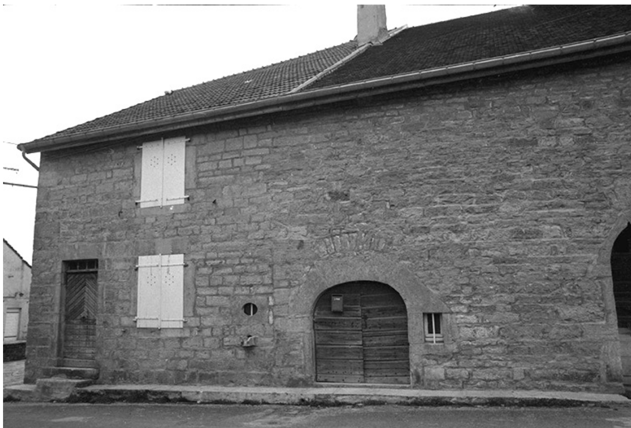
Ferme cadastrée 1965 AB 249 et 252 : façade antérieure.
