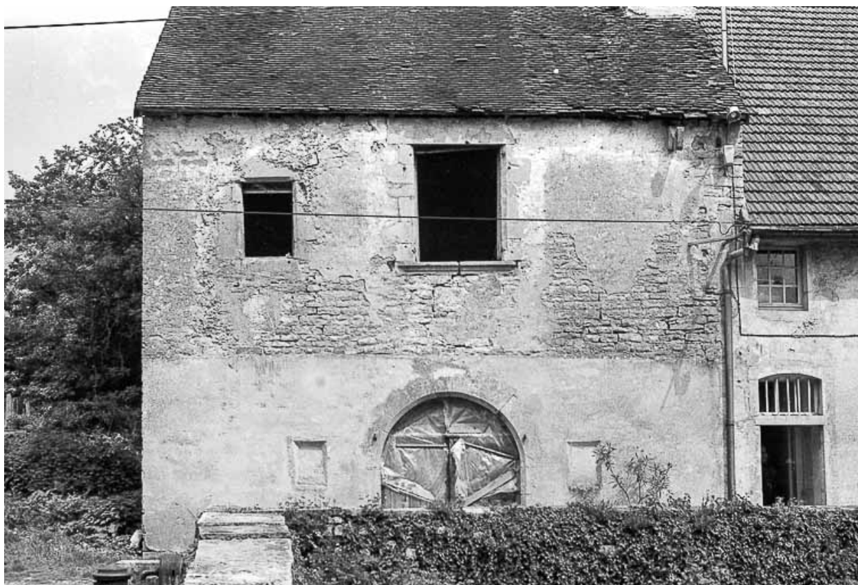
Maison attenante au presbytère : façade postérieure.
