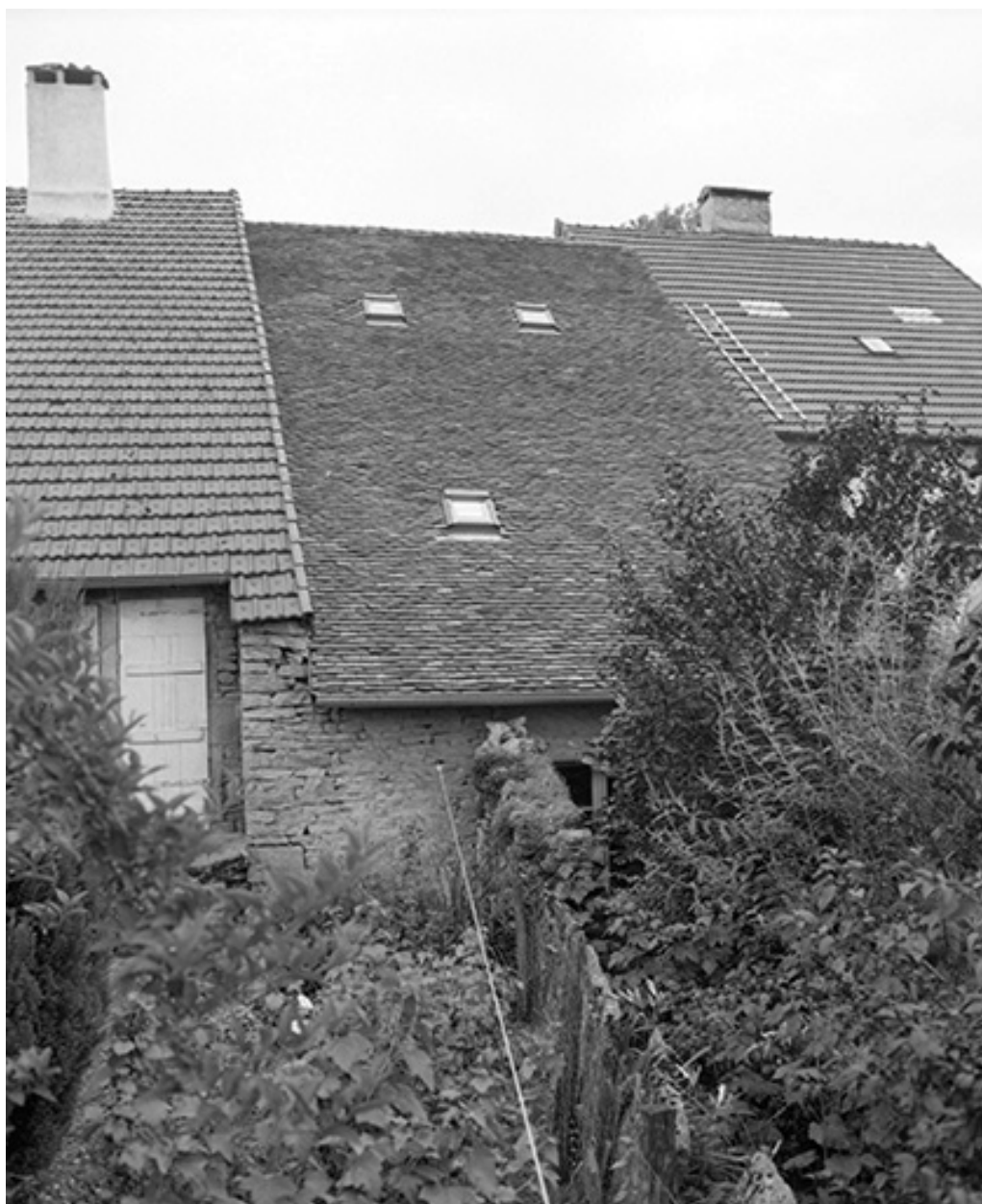
Maisons situées rue de l'Eglise : façades postérieures.
