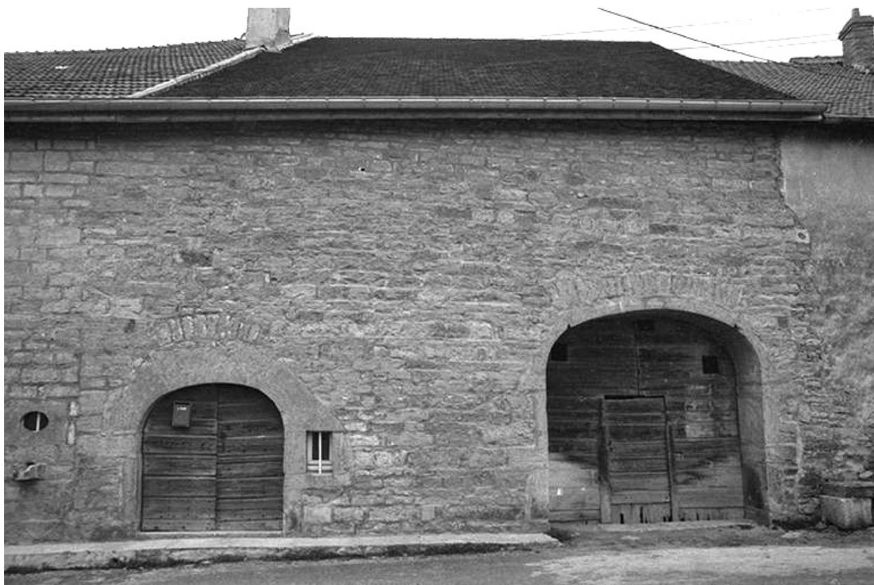
Ferme cadastrée 1965 AB 249 et 252 : façade antérieure.
