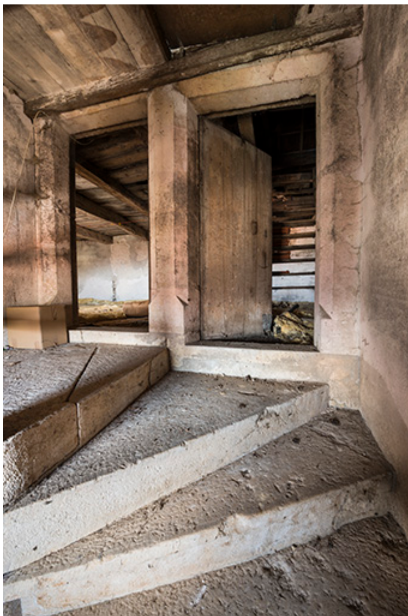
Portes d'accès aux combles depuis la tour.
