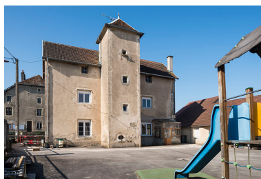
La maison depuis la cour de l'école. Phot. Jérôme Mongreville IVR43_20177000174NUC4A
