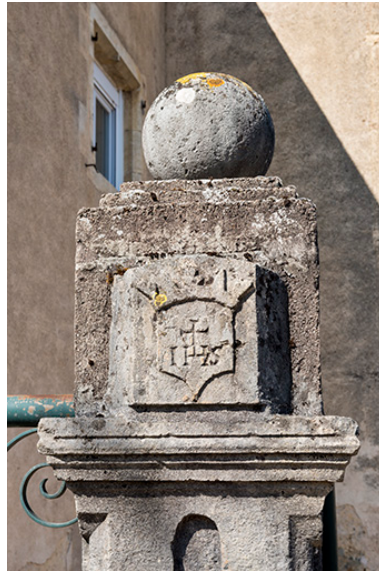
Détail d'un pilier. Phot. Jérôme Mongreville IVR43_20177000176NUC4A
