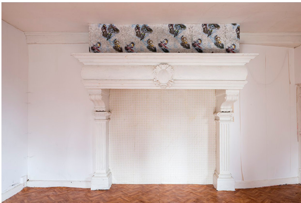
Cheminée, premier étage.
