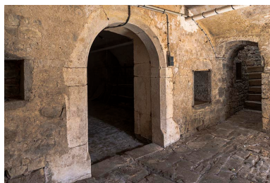
Porte de séparation de la cave. Phot. Jérôme Mongreville IVR43_20177000114NUC4A
