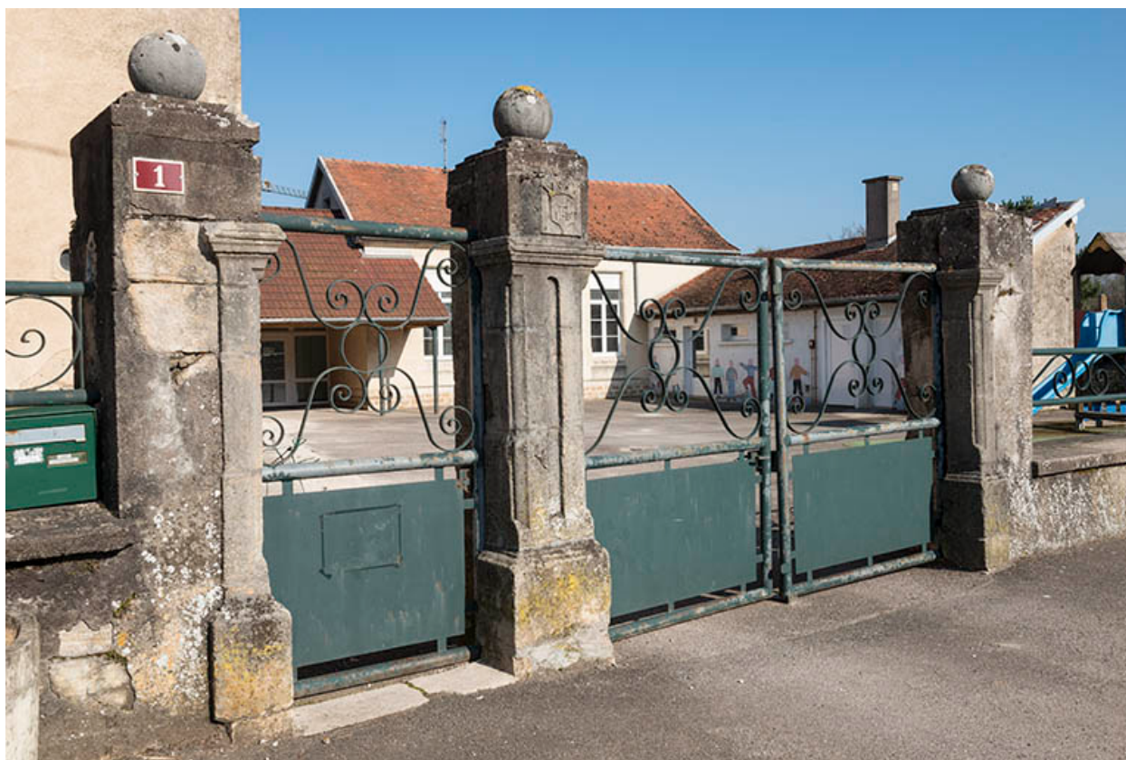
L'entrée depuis la rue.
