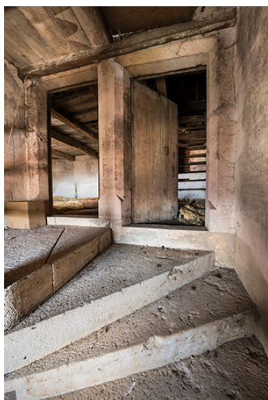
Portes d'accès aux combles depuis la tour. Phot. Jérôme Mongreville IVR43_20177000111NUC4A
