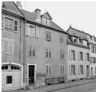
Façade sur rue. Phot. Jérôme Mongreville IVR43_19872500354X
