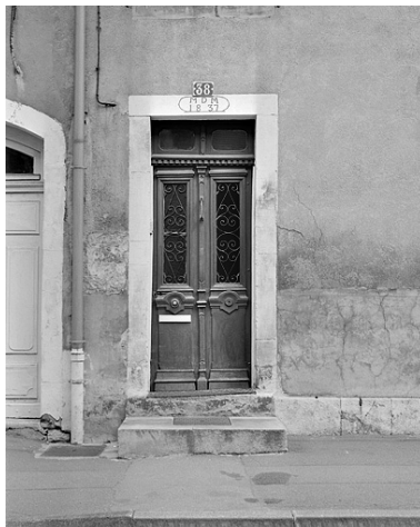
Façade sur rue. Détail de la porte. Phot. Jérôme Mongreville IVR43_19872500355X
