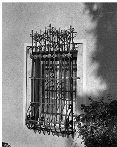
Une des baies du rez-de- chaussée des communs. Phot. Yves Sancey IVR43_19802500915X
