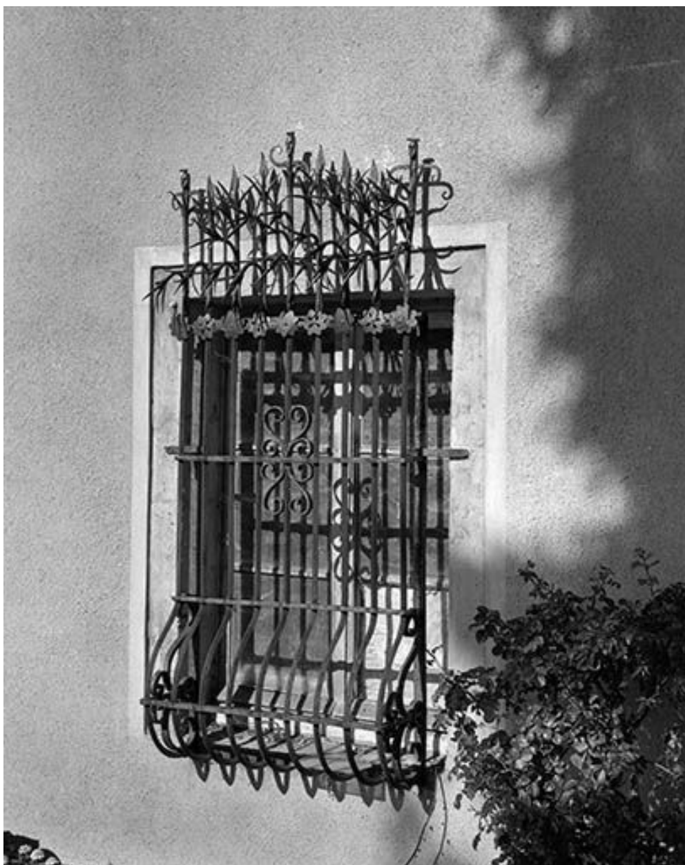
Une des baies du rez-de-chaussée des communs.
