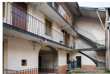
Façade postérieure. Phot. Jérôme Mongreville IVR43_20177000473NUC4A
