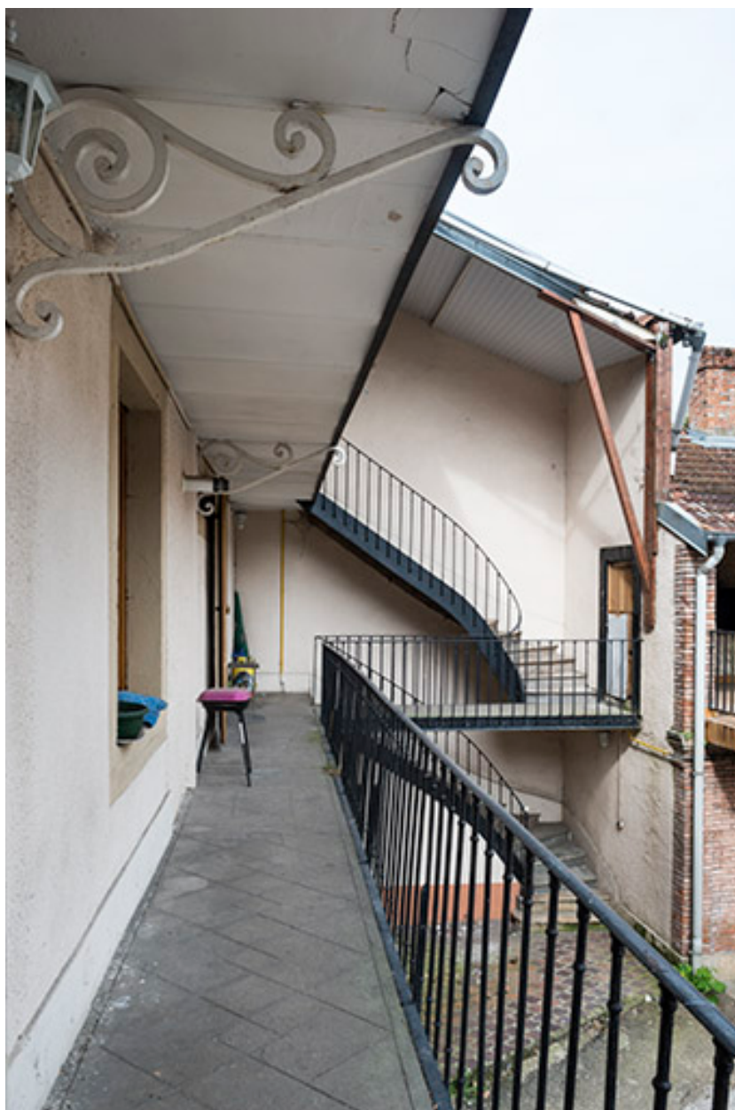
Escalier à cage ouverte, façade postérieure.
