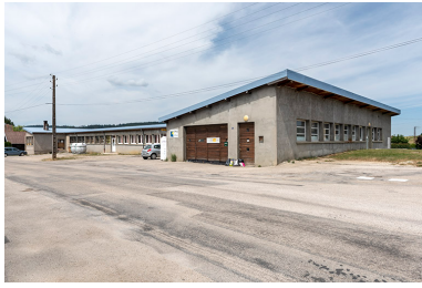
Façades antérieure et latérale droite.
