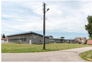
Façades postérieure et latérale droite.
