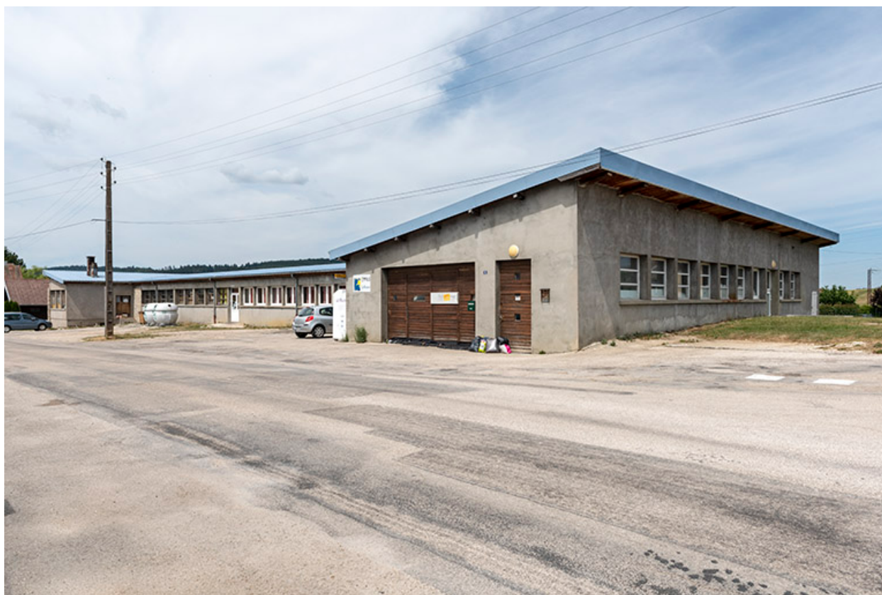
Façades antérieure et latérale droite.
