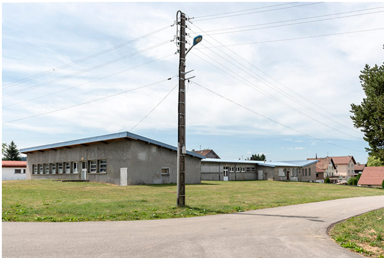
Façades postérieure et latérale droite.
