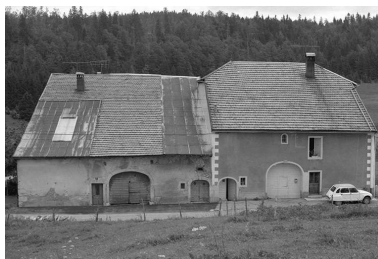
Fermes datées de 1880 et 1706, situées 15 et 15 bis avenue des Turquoises : façades antérieures. Phot. Gilbert Poinot IVR43_19752500984Z
