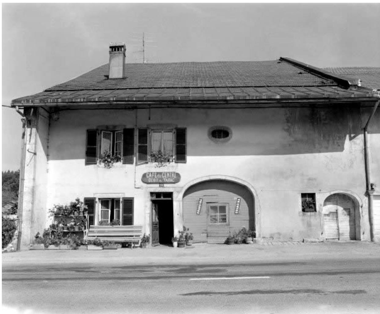
Ferme située 14 avenue des Turquoises : façade antérieure.
