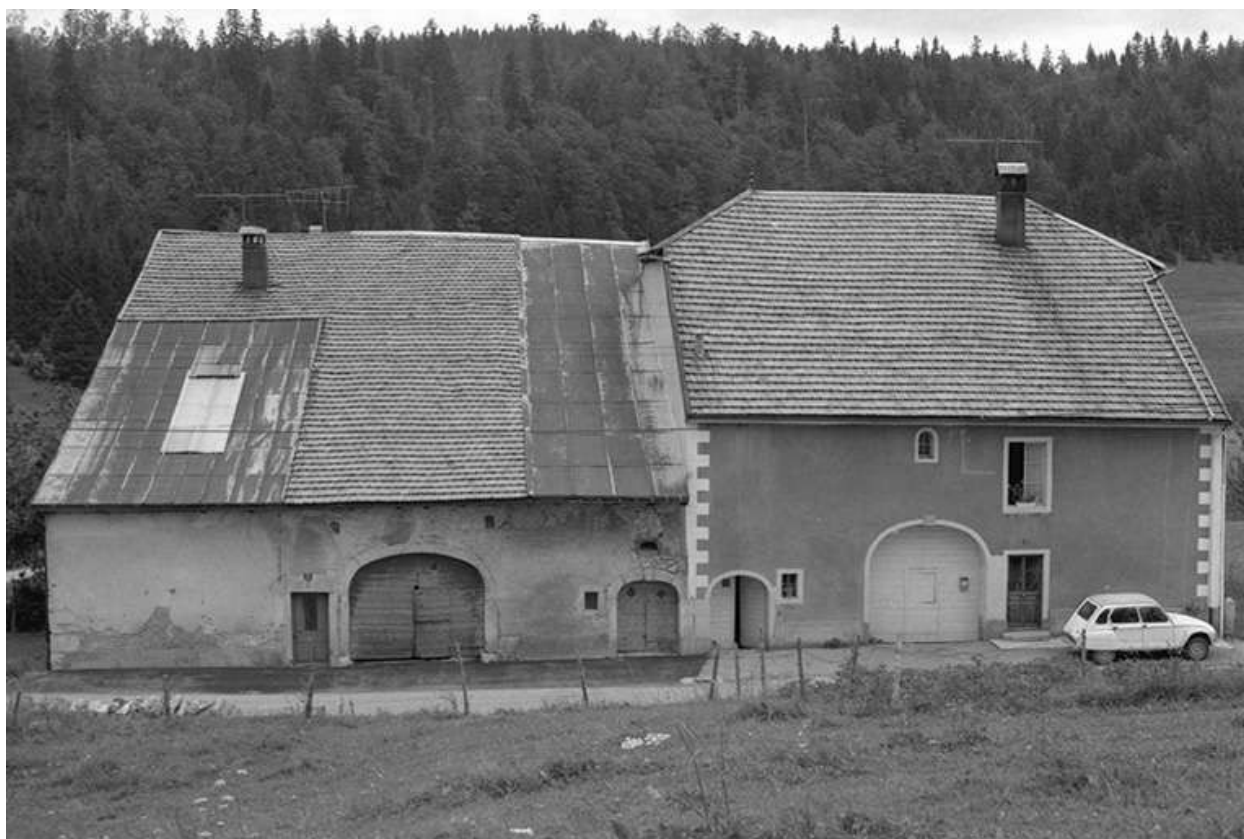
Fermes datées de 1880 et 1706, situées 15 et 15 bis avenue des Turquoises : façades antérieures.
