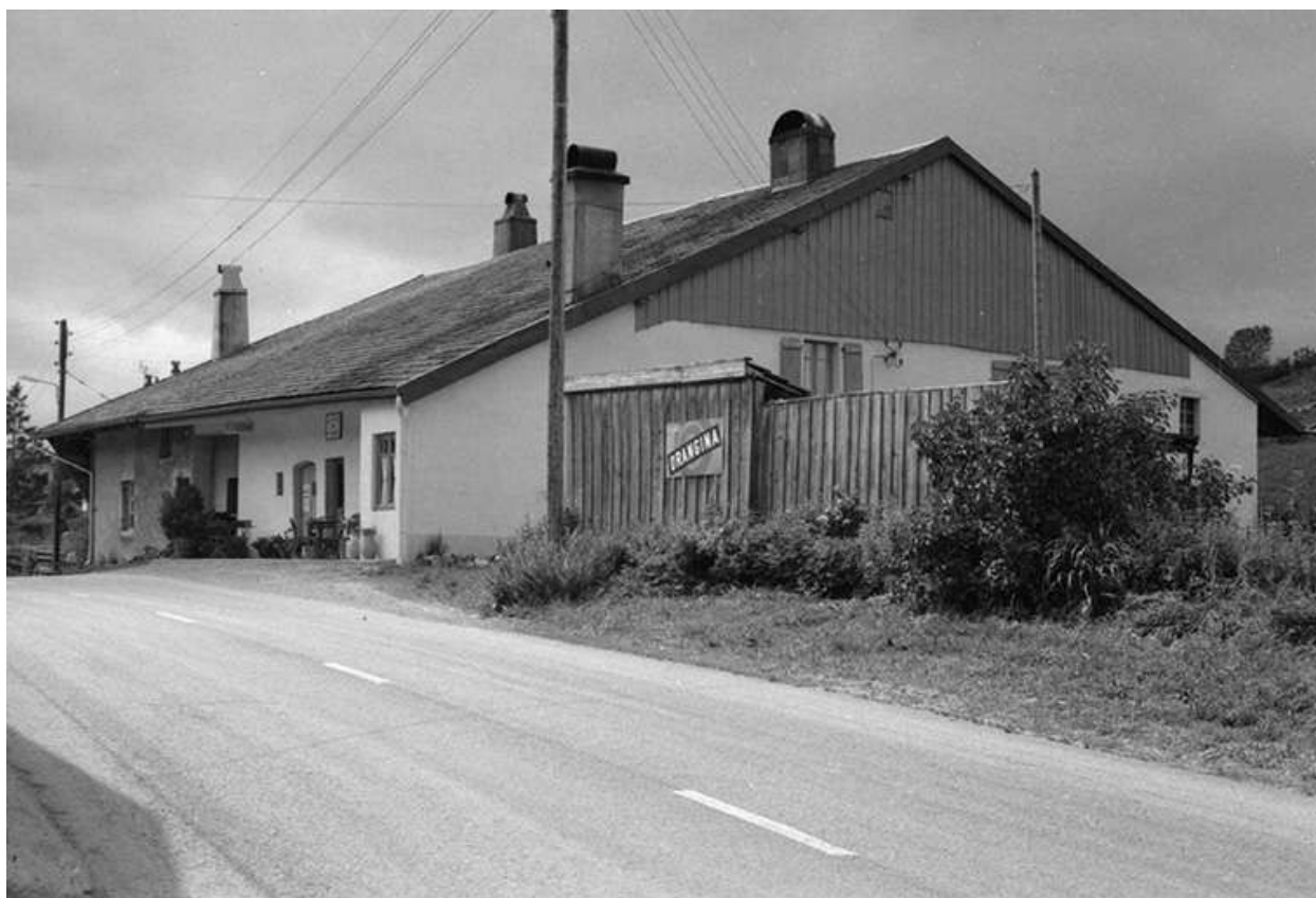
Ferme datée de 1774, située avenue des Turquoises : façade antérieure et pignon droit.
