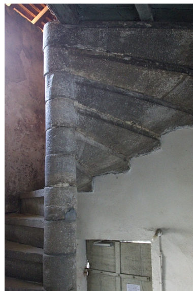
Deuxième logis secondaire : détail d'escalier en vis.
