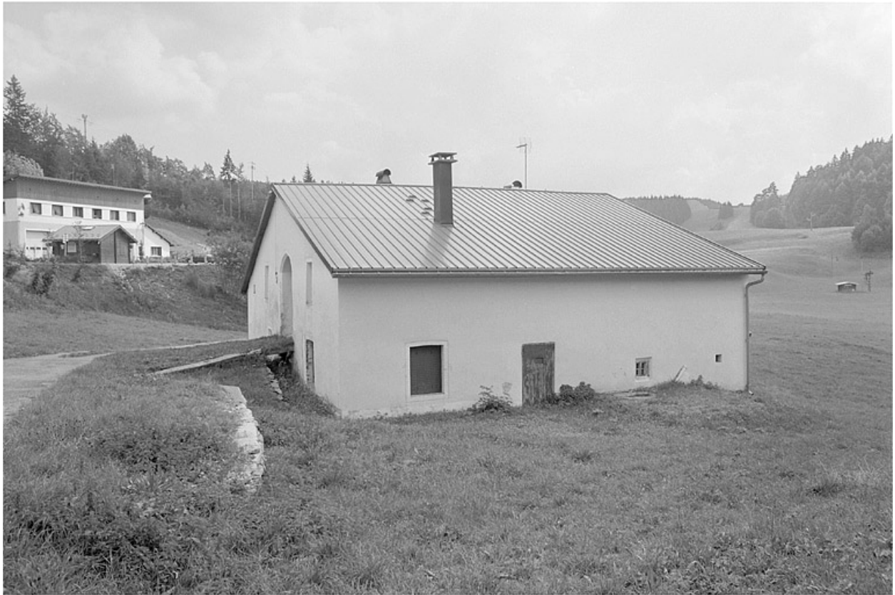
Façade postérieure et face nord-est.
