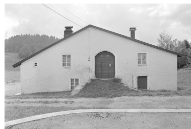
Face nord-est. Phot. Jérôme Mongreville IVR43_19963901400X
