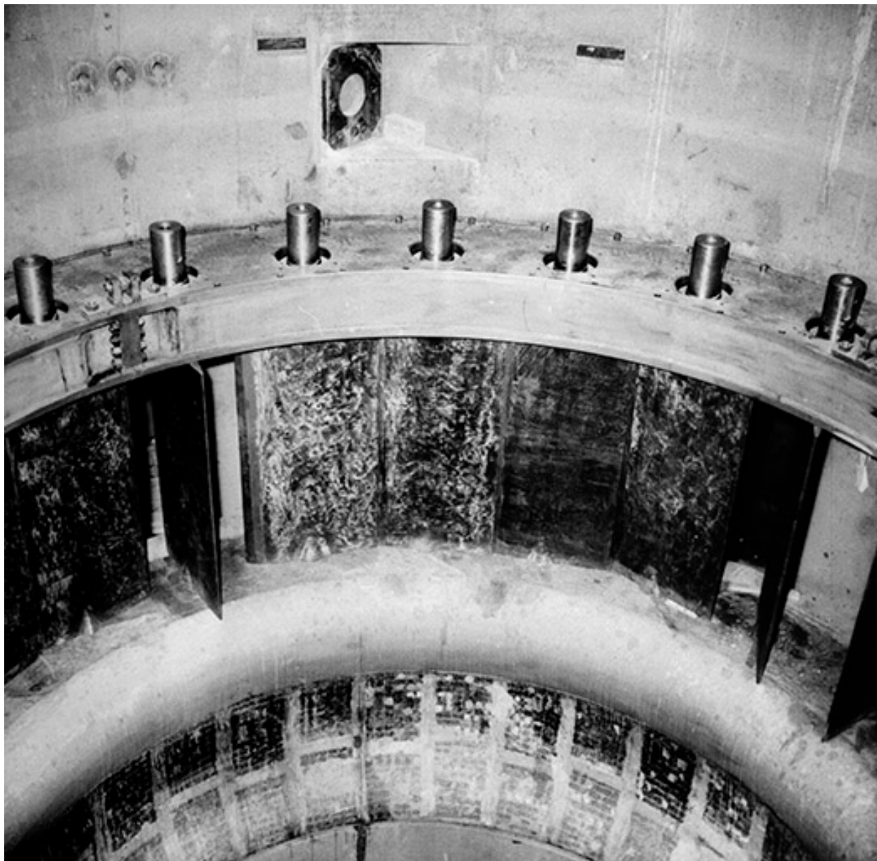
Turbine G.1 : distributeur en cours de montage.
