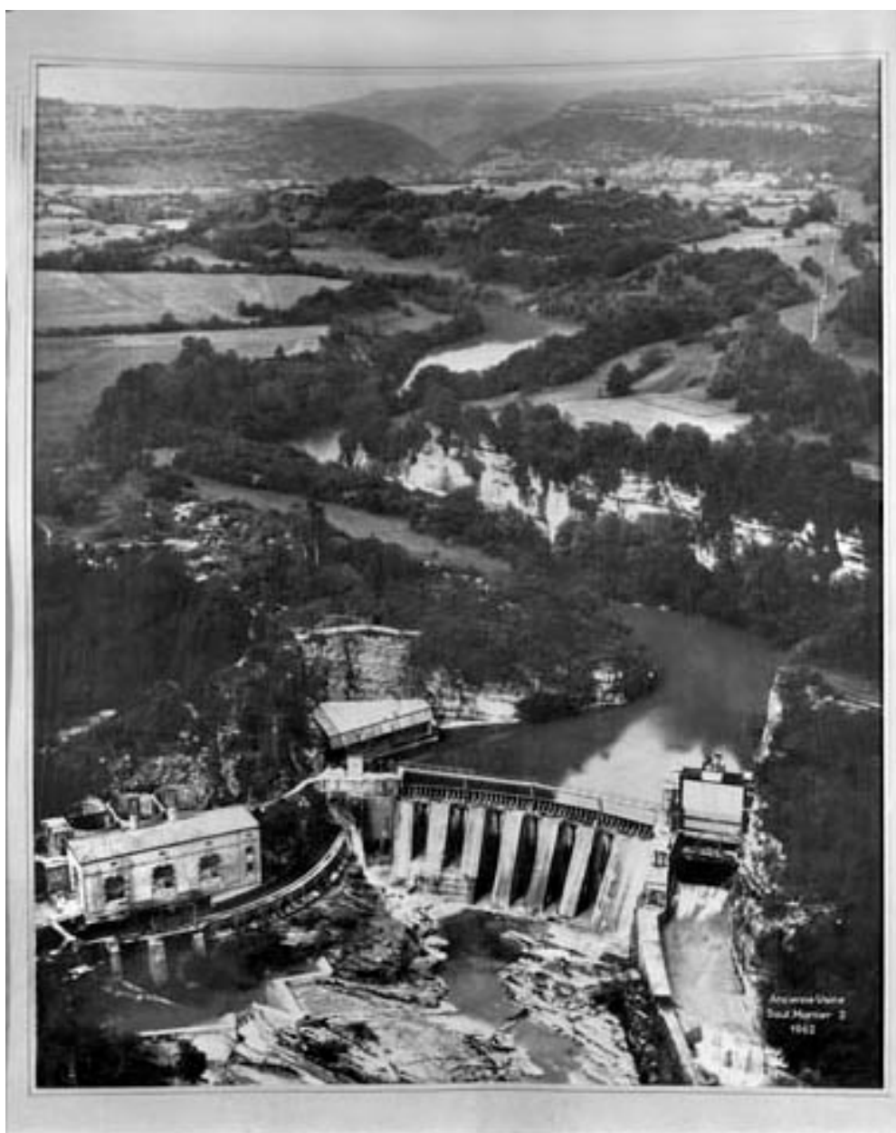
Ancienne Usine Saut-Mortier 2 [vue aérienne].
