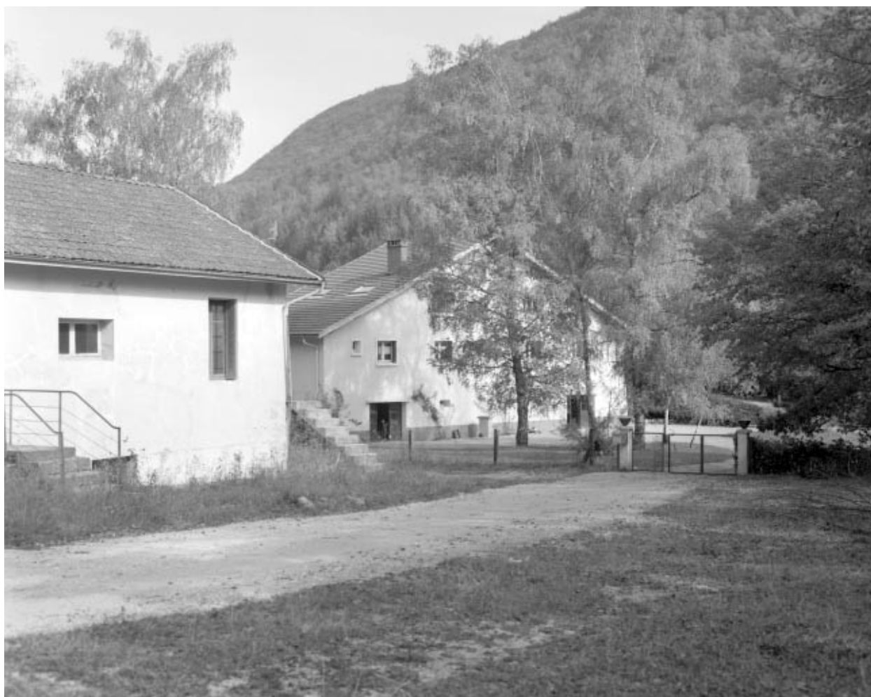
Logement de contremaître.
