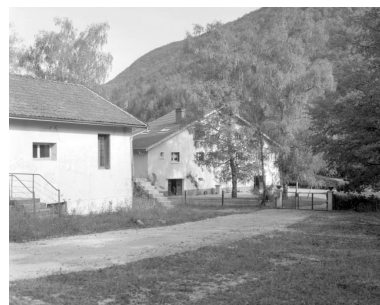
Logement de contremaître. Phot. Jérôme Mongreville IVR43_19913900657X
