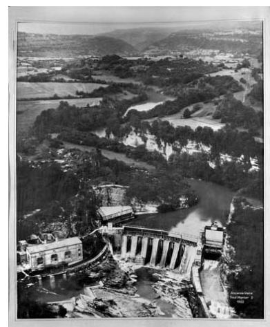
Ancienne Usine Saut- Mortier 2 [vue aérienne]. Phot. Jérôme Mongreville IVR43_19913900640V
