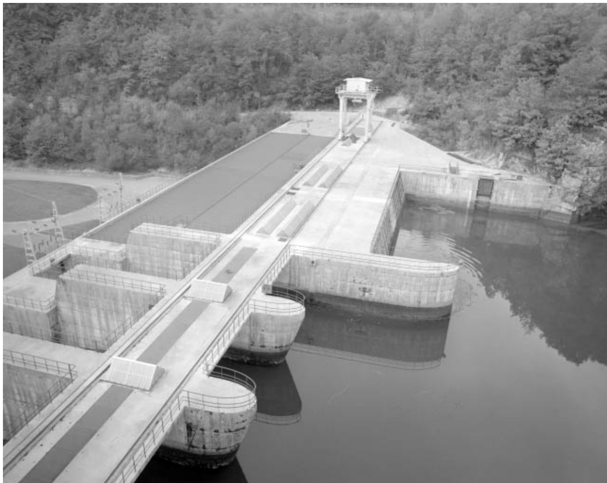
Evacuateur de crue et toiture de l'usine.
