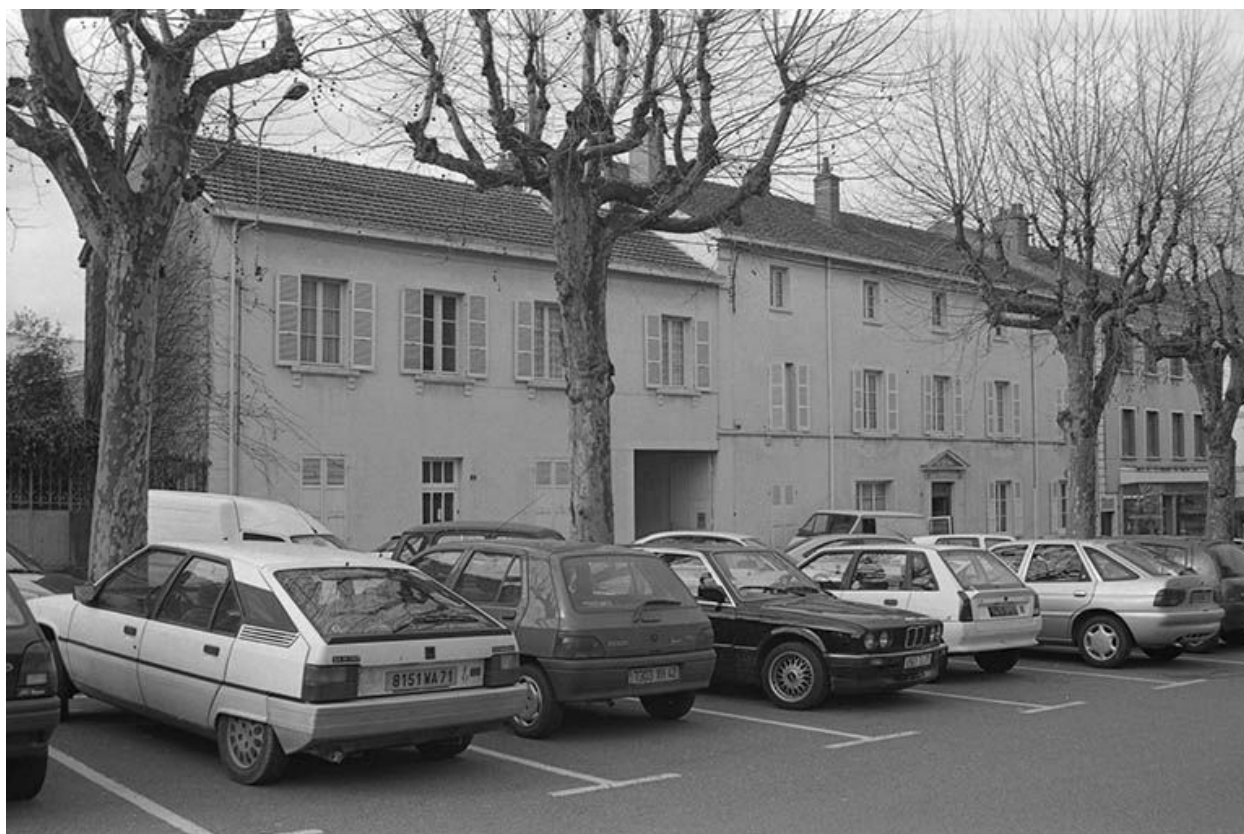
Façade antérieure du presbytère, vue de l'est.
