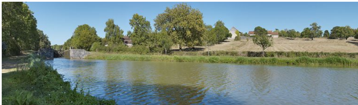
Vue générale du site d'écluse, d'aval.
