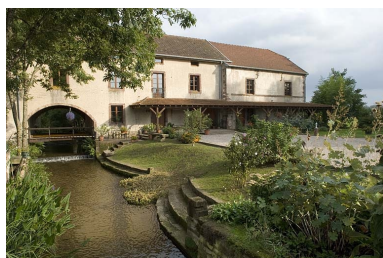
Façade antérieure. Phot. Jérôme Mongreville IVR43_20067000759NUCA
