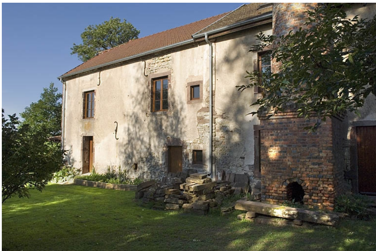
Partie sud (logement) de la façade postérieure.
