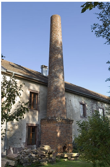
Cheminée. Phot. Jérôme Mongreville IVR43_20067000761NUCA
