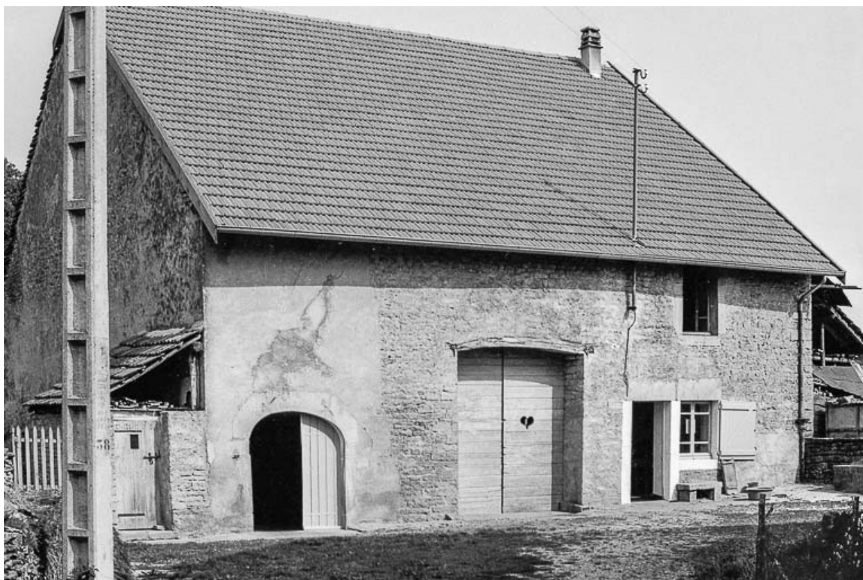
Ferme cadastrée B3 274 : façade antérieure.
