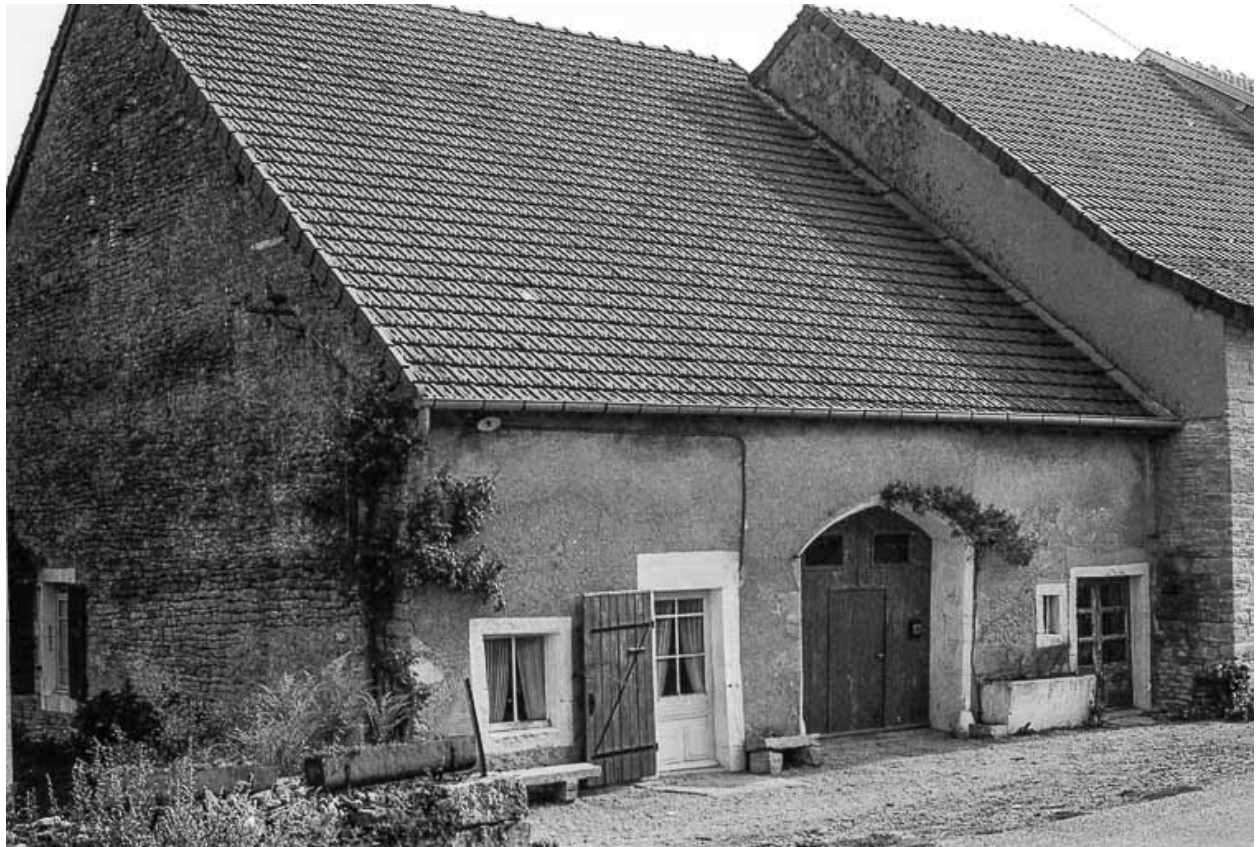
Ferme cadastrée A3 170 : façade antérieure.
