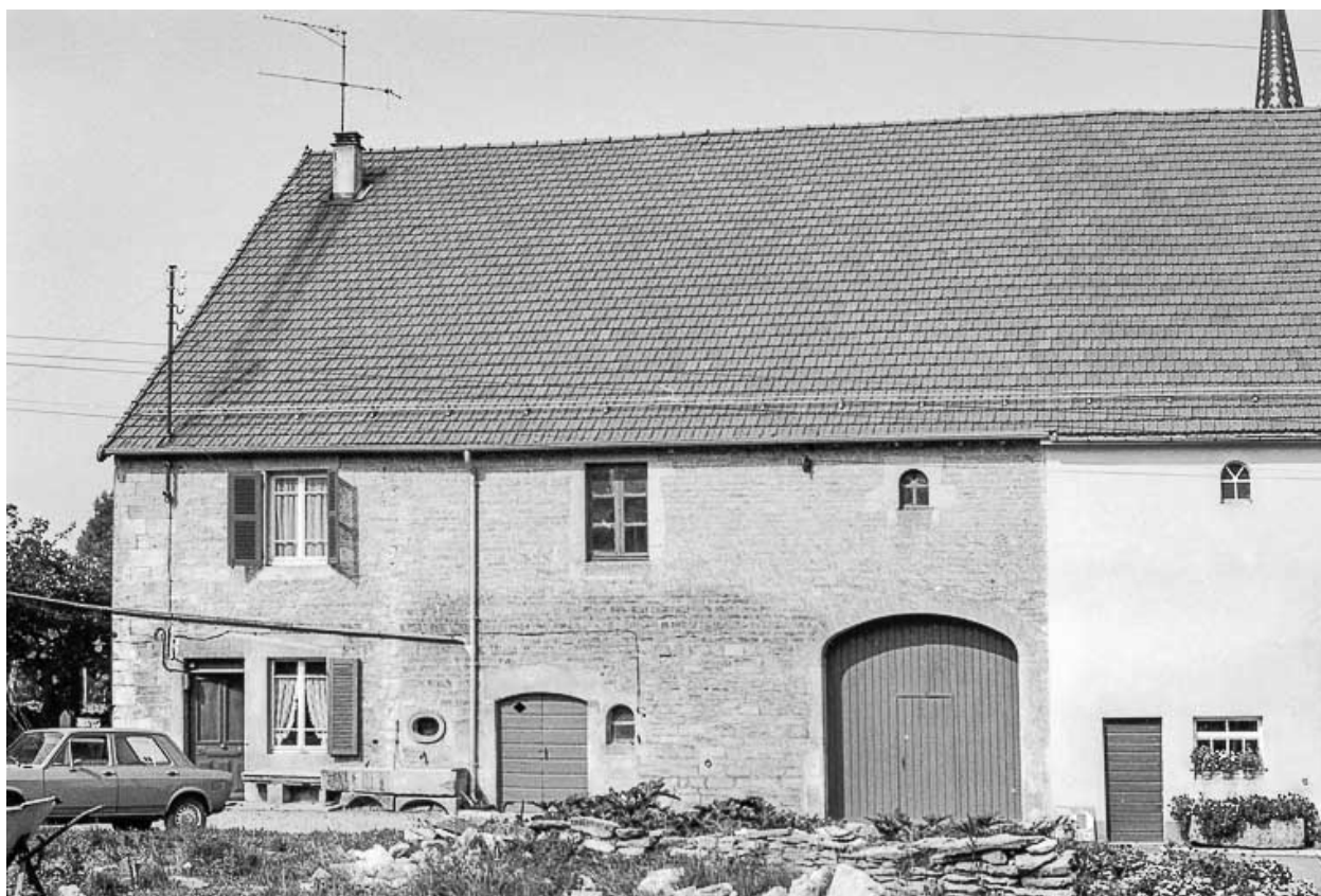
Ferme cadastrée C1 20 : façade antérieure.
