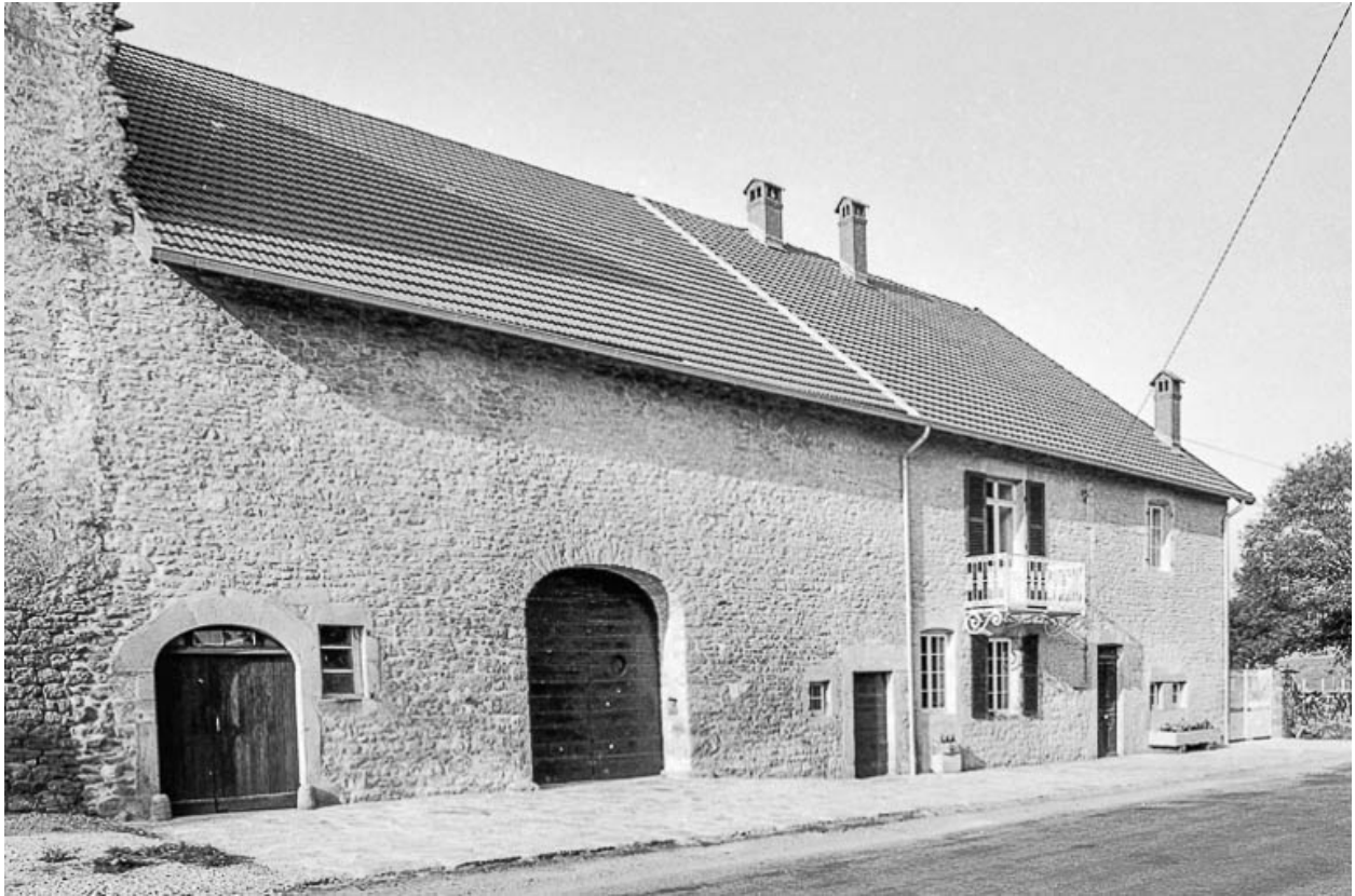
Ferme cadastrée A3 218 : façade antérieure.
