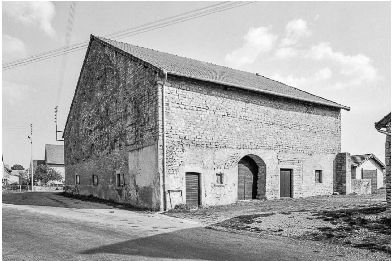
Ferme cadastrée A3 206 : façade postérieure.
