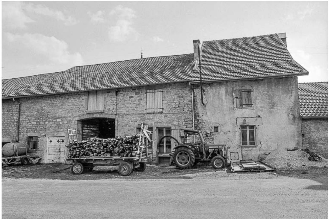
Ferme cadastrée A3 194 : façade antérieure.
