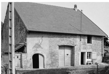
Ferme cadastrée B3 274 : façade antérieure. Phot. Bernard Pontefract IVR43_19763900374Z
