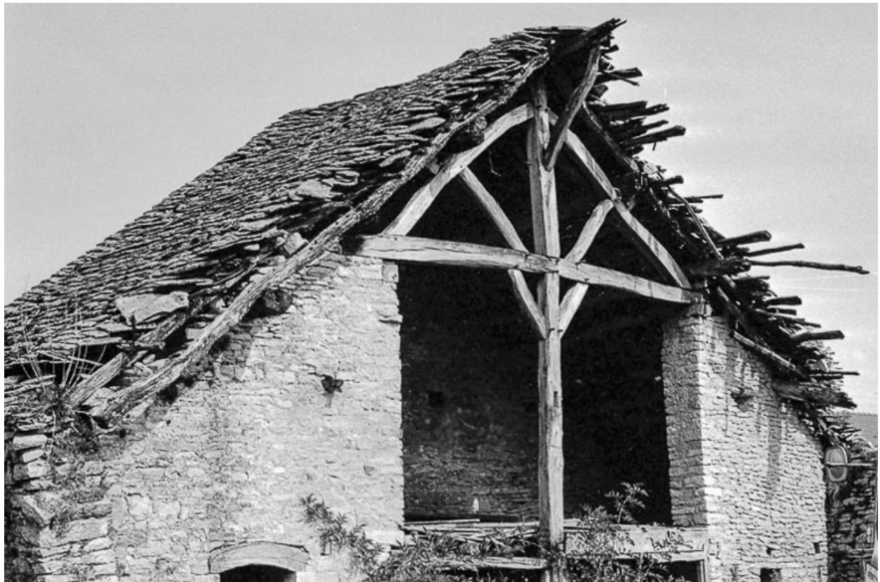
Ferme cadastrée B3 256 : toiture.
