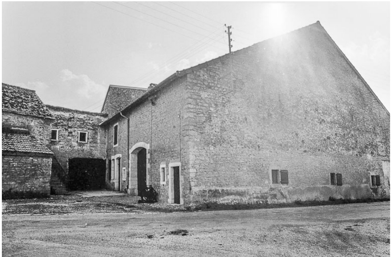
Ferme cadastrée A3 206 : façade antérieure.
