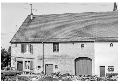
Ferme cadastrée C1 20 : façade antérieure. Phot. Bernard Pontefract IVR43_19763900371Z
