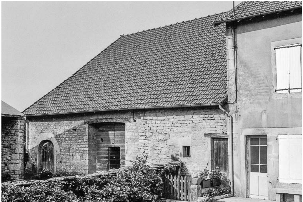
Ferme cadastrée C1 24 : façade antérieure.
