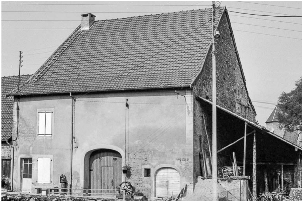
Ferme cadastrée C1 25 : façade antérieure.
