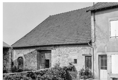
Ferme cadastrée C1 24 : façade antérieure. Phot. Bernard Pontefract IVR43_19763900373Z
