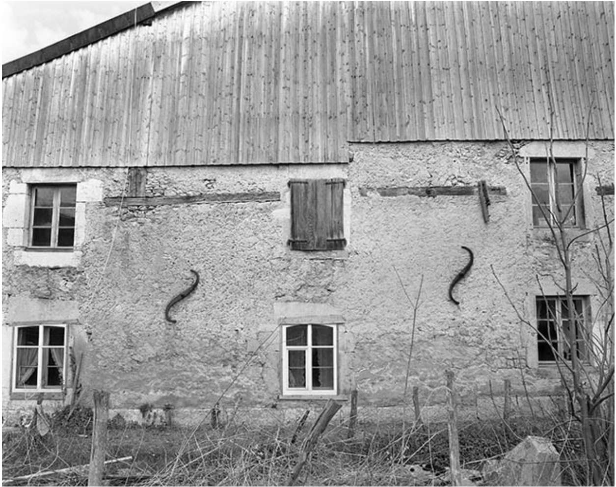
Détail du pignon d'habitation.
