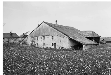
Extérieur : pignon de l'habitation et goutterot postérieur. Phot. Dominique Dominguez IVR43_19792500162X
