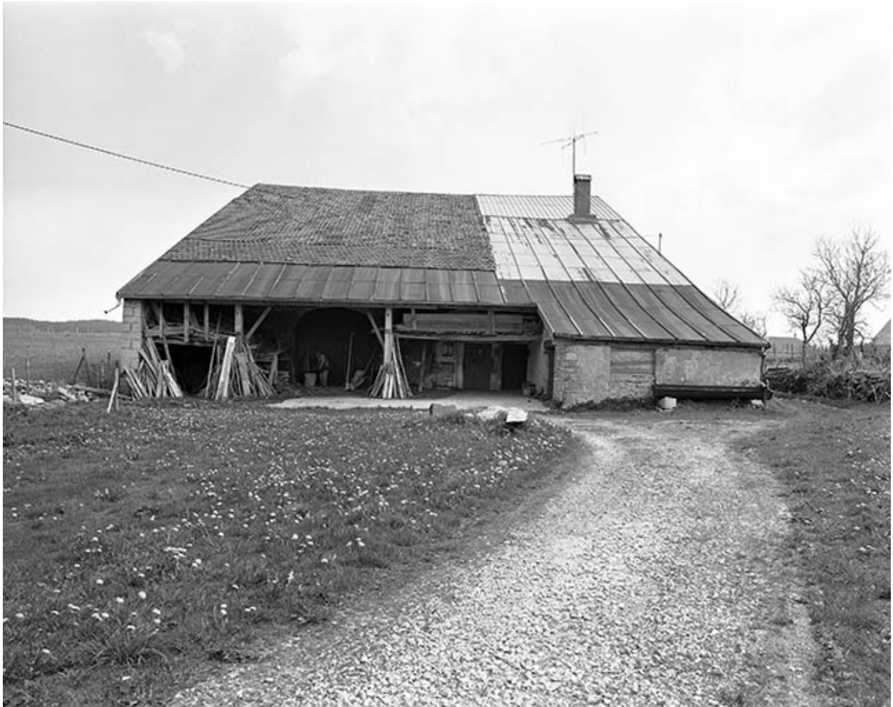
Extérieur : gouttereau antérieur.
