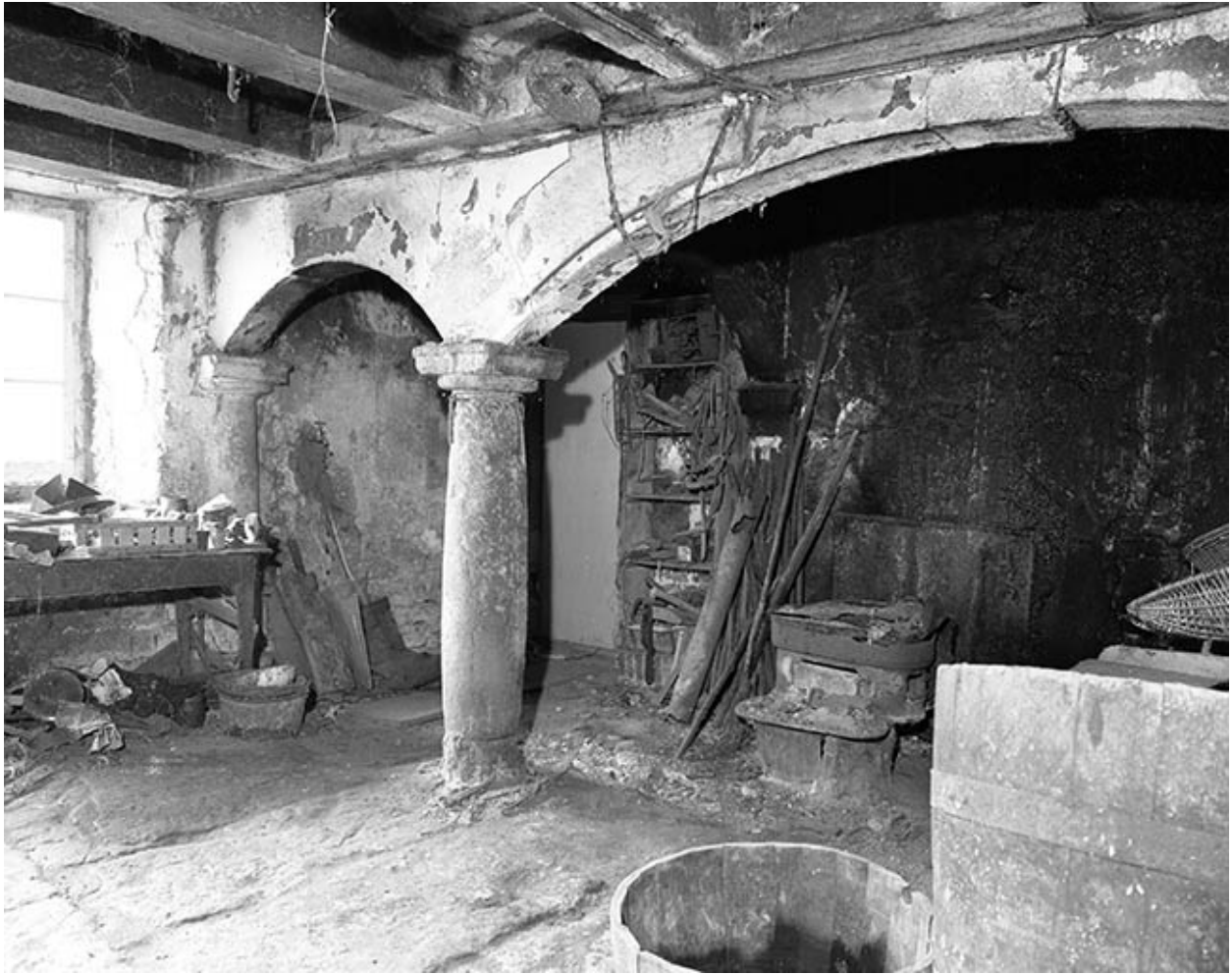
Cheminée de la deuxième cuisine.
