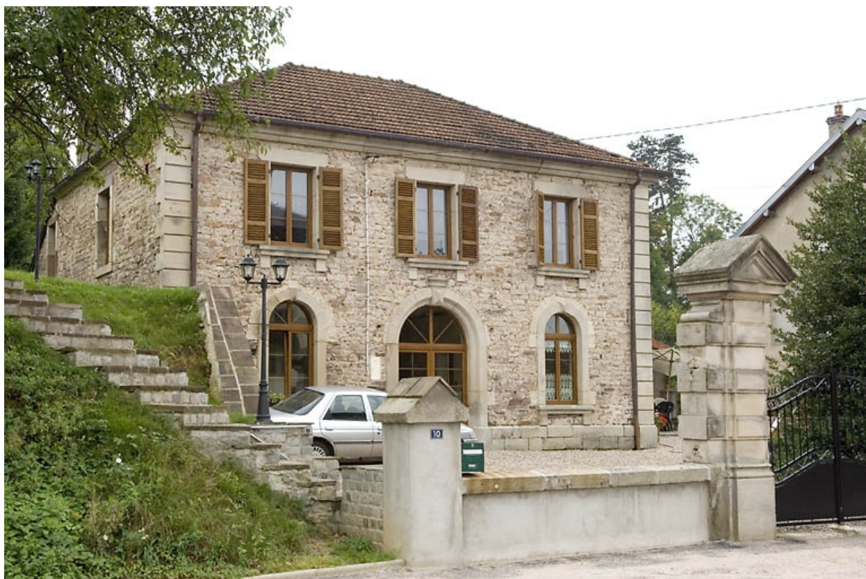
Façade antérieure. Vue de trois quarts.
