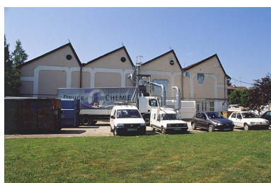
Face arrière. Phot. Yves Sancey IVR43_20009000552ZA
