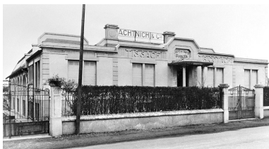
Façade de l'usine. Phot. Yves Sancey IVR43_20009000895X
