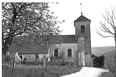
Face latérale gauche. Phot. Yves Sancey IVR43_19792500086X
