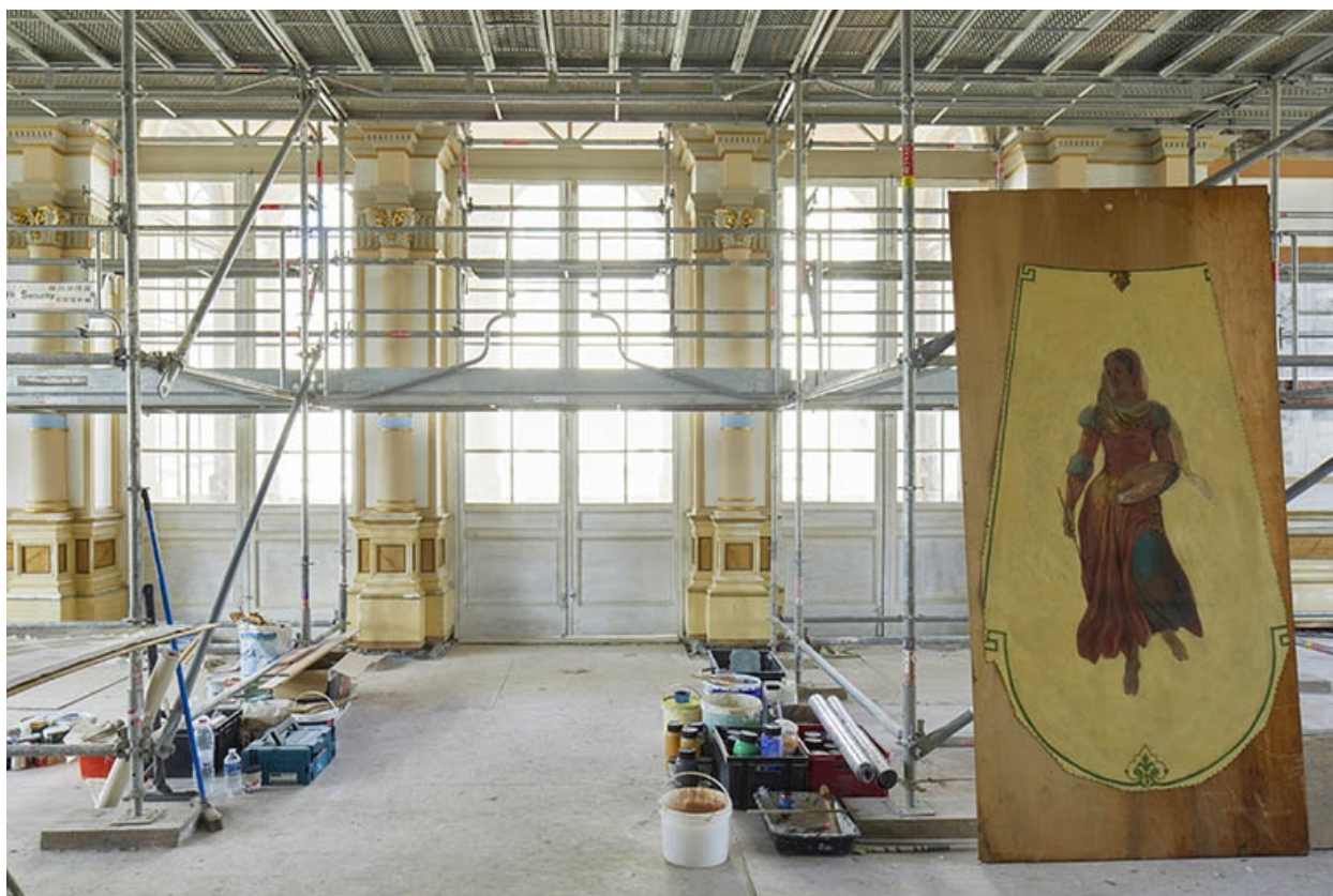
Foyer en cours de restauration en 2020. A droite, l'allégorie de la Peinture, décor du plafond de la salle.
