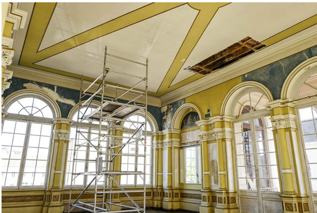
Foyer en cours de restauration, en 2020.
