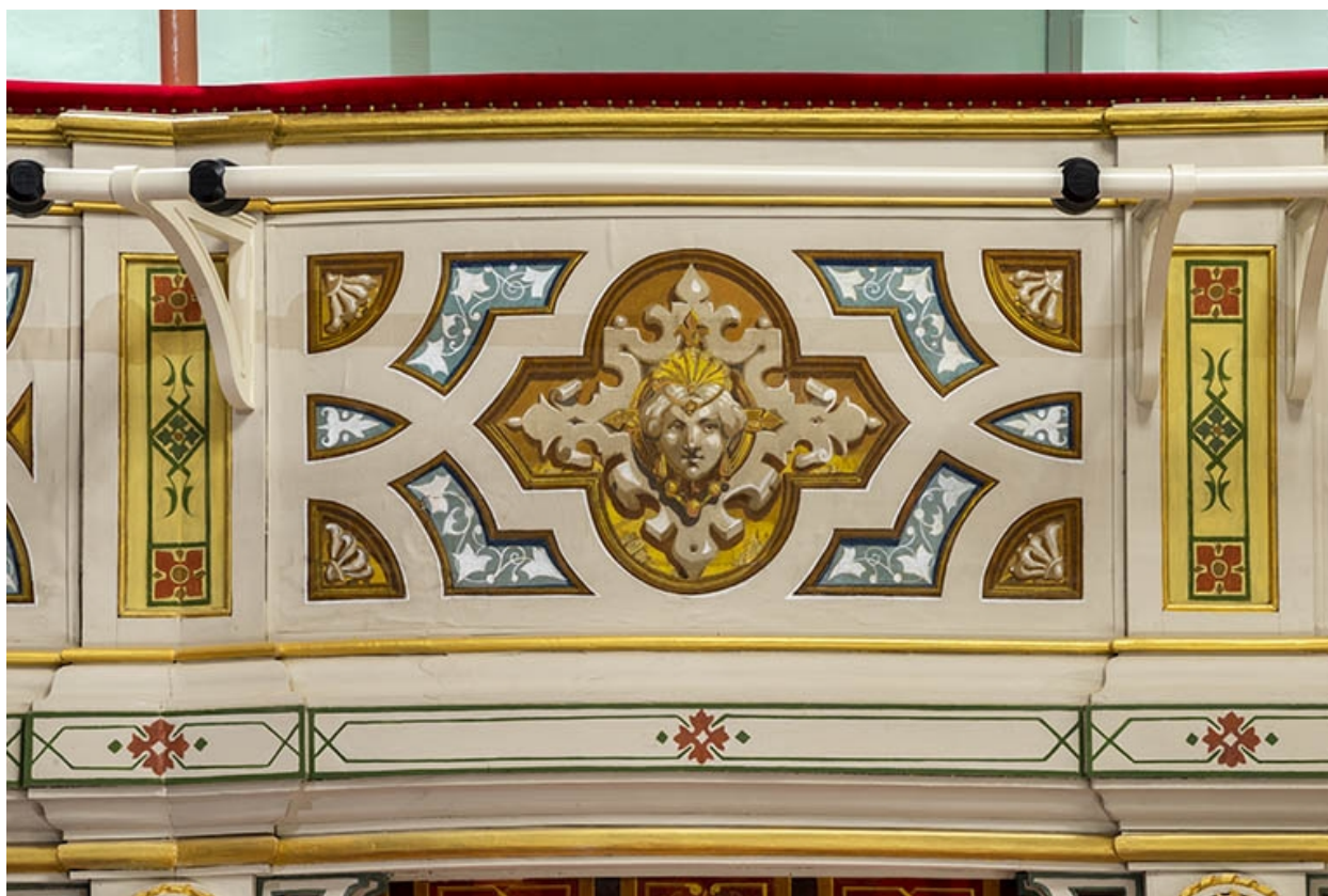
Salle : décor du garde-corps du 2e balcon.
