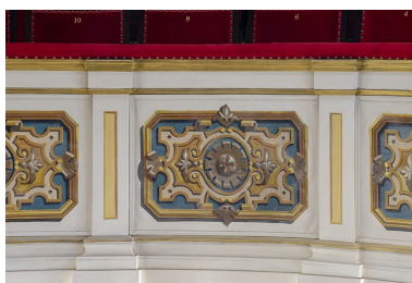
Salle : décor du garde-corps du 1er balcon. Phot. Jérôme Mongreville IVR43_20223900227NUC4A
