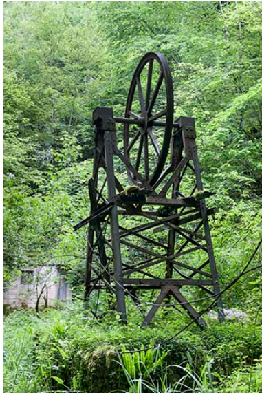
Support métallique (amont) de la transmission par câble. Phot. Jérôme Mongreville IVR43_20162500400NUC4A
