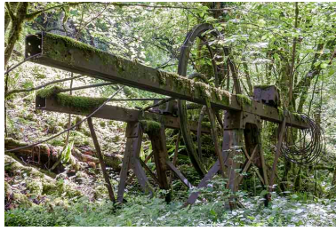
Support métallique (aval) de la transmission par câble. Phot. Jérôme Mongreville IVR43_20162500404NUC4A
