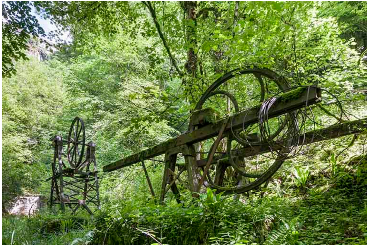
Supports métalliques de la transmission par câble.
