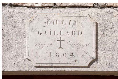
Linteau de porte du moulin. Phot. Jérôme Mongreville IVR43_20152501844NUC4A
