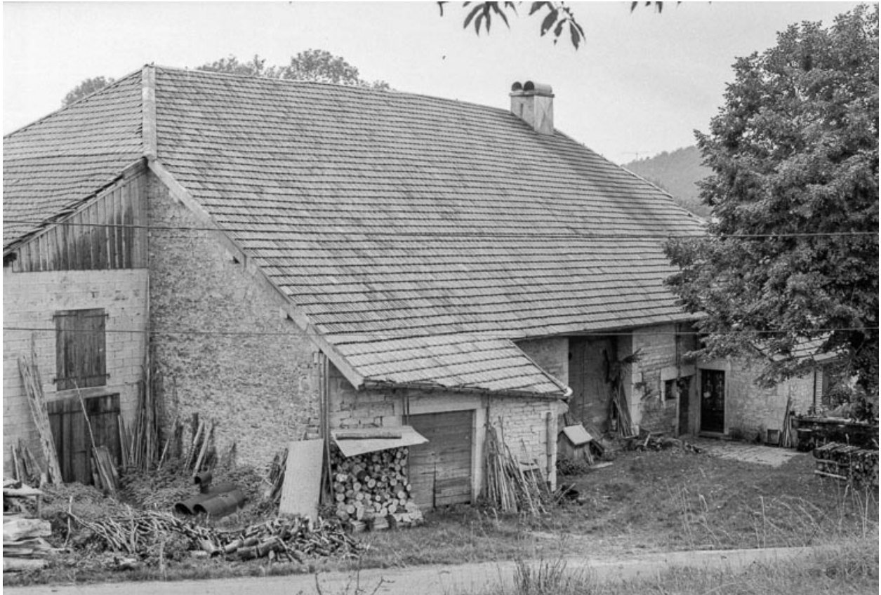
Ferme cadastrée 1939 F 28 : vue d'ensemble.
