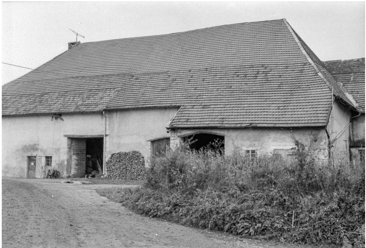
Ferme cadastrée 1939 F 2-3 : façade latérale droite.
