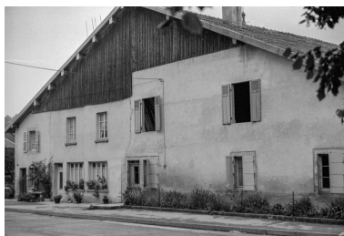
Ferme cadastrée 1939 F 183-184 : façade antérieure. Phot. Gilbert Poinot IVR43_19752501374Z
