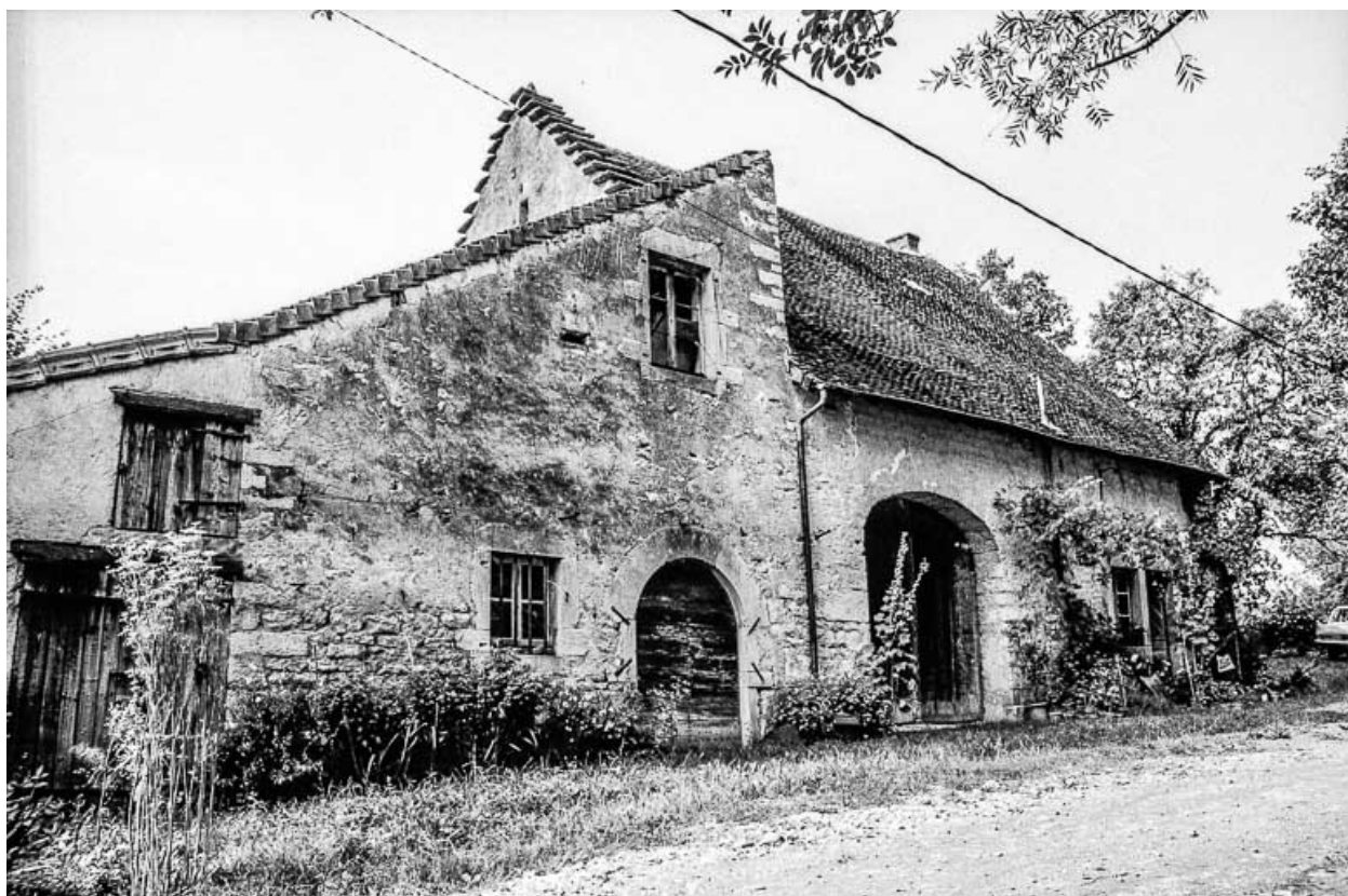
Ferme cadastrée 1964 AC 48 : vue d'ensemble.
