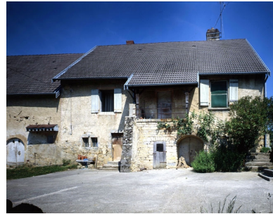
Ferme située rue Charles Nodier. Phot. Yves Sancey IVR43_19903901167VA
