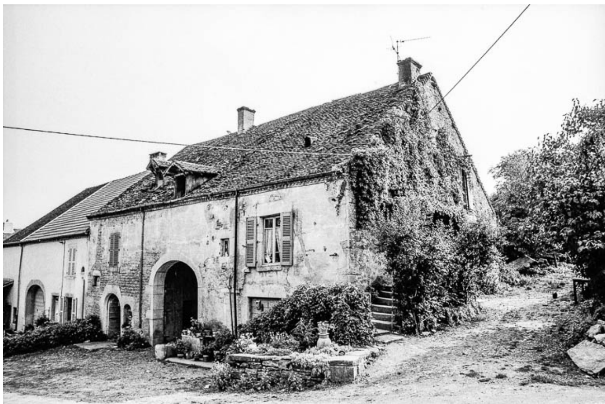
Ferme cadastrée 1964 AC 54 : vue d'ensemble.
